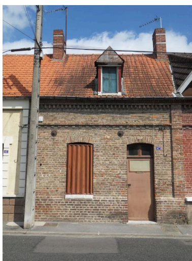
Façade d'un logement. Phot. Isabelle Barbedor IVR22_20108001500NUCA
