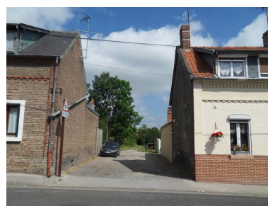
Ancien chemin donnant accès à l'usine, depuis la rue Ambroise-Coizat Phot. Isabelle Barbedor IVR22_20108001538NUCA
