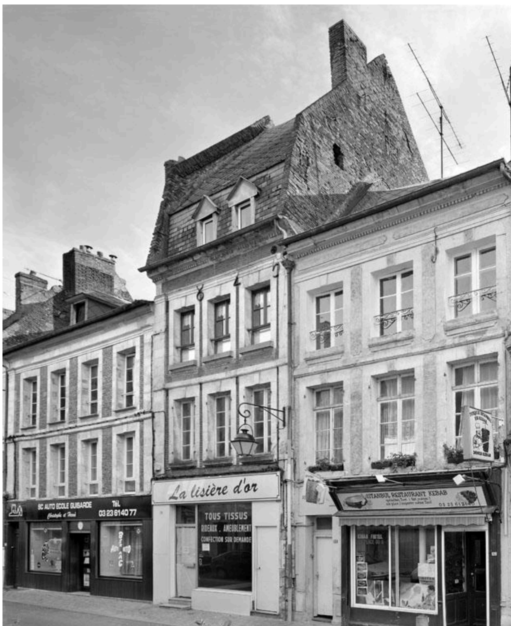
Vue de la façade sur rue.
