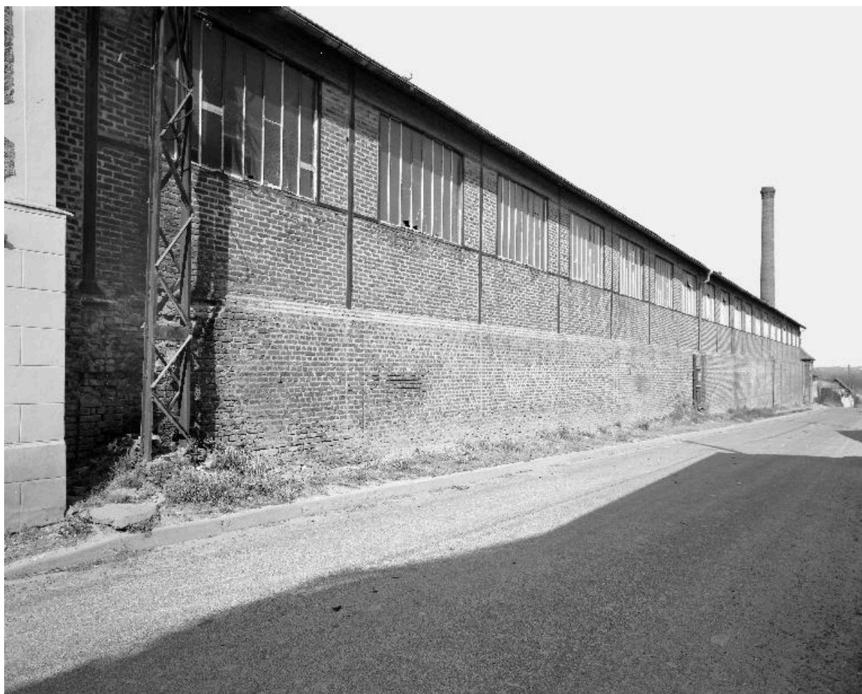
Atelier de fabrication, élévation antérieure.
