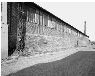
Atelier de fabrication, élévation antérieure. Phot. Thierry Lefebvre IVR22_19888000625V
