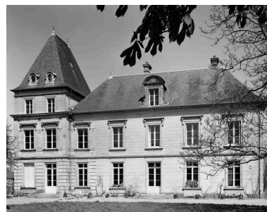
Élévation antérieure. Phot. Jean-Michel Perrin IVR22_19856000552V
