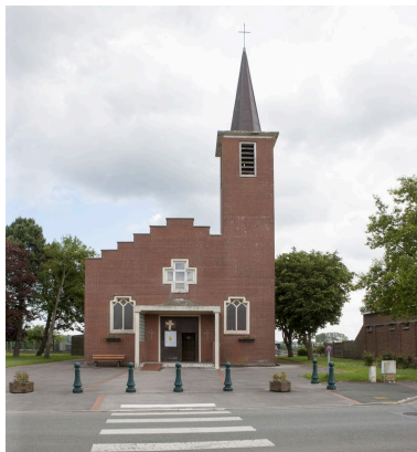
Élévation antérieure. Phot. Pierre Thibaut IVR31_20155901097NUCA
