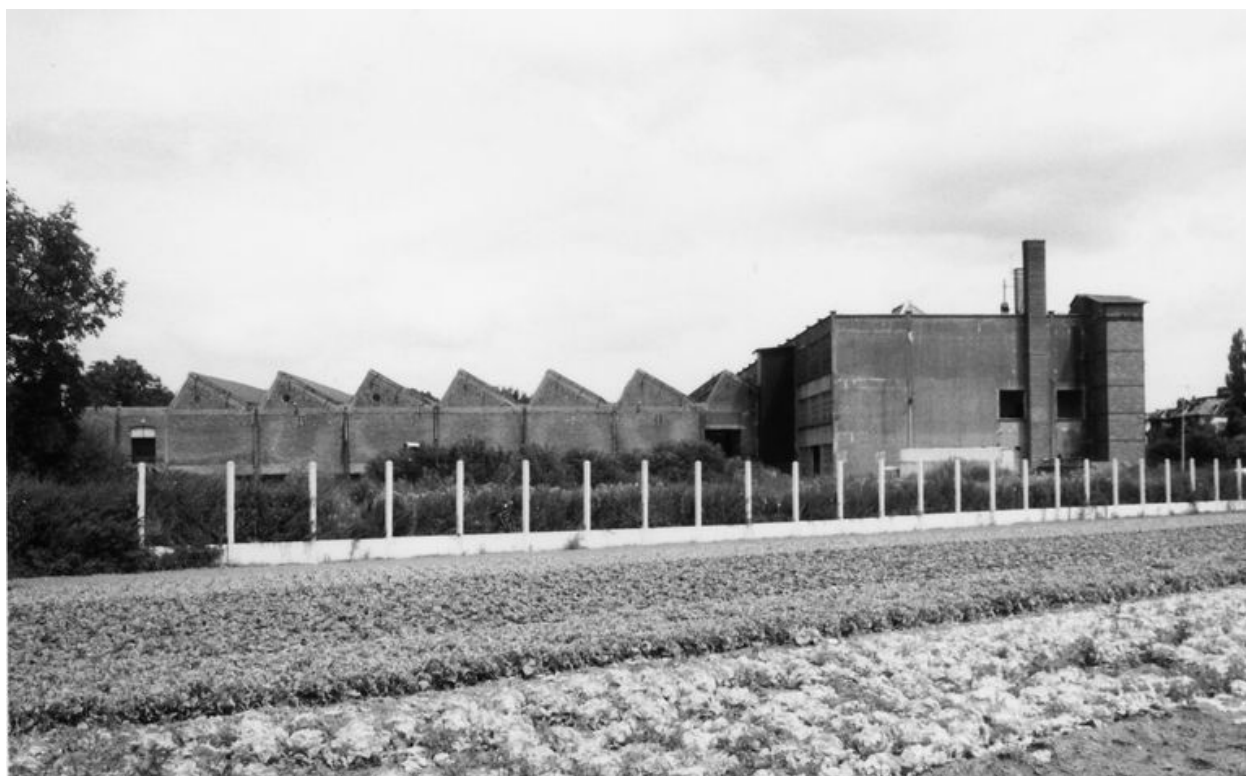
Atelier de fabrication (tissage), flanc sud.
