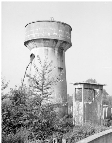
Château d'eau. Phot. Thierry Lefébure IVR22_19898000367X
