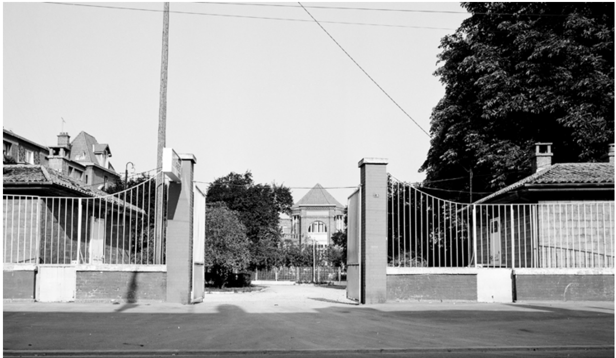
Entrée de l'établissement.
