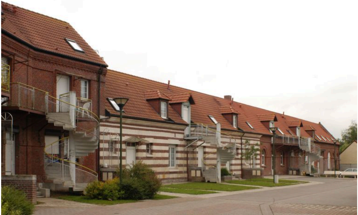
Anciennes dépendances du château : côté cour.
