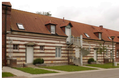
Anciennes dépendances du château : corps central côté cour. Phot. Thierry Lefébure IVR22_20038000455NUCA
