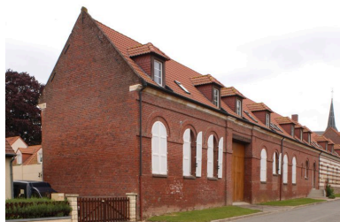
Anciennes dépendances du château : corps latéral ouest, côté rue. Phot. Thierry Lefébure IVR22_20038000453NUCA
