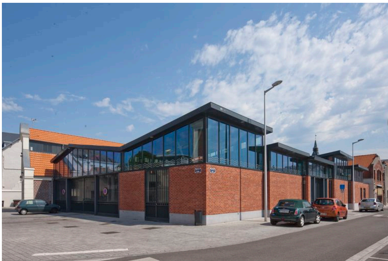
Vue générale depuis la rue des halles.
