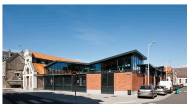
Vue générale depuis la rue des Garennes. Phot. Hubert Bouvet IVR31_20136200236NUCA
