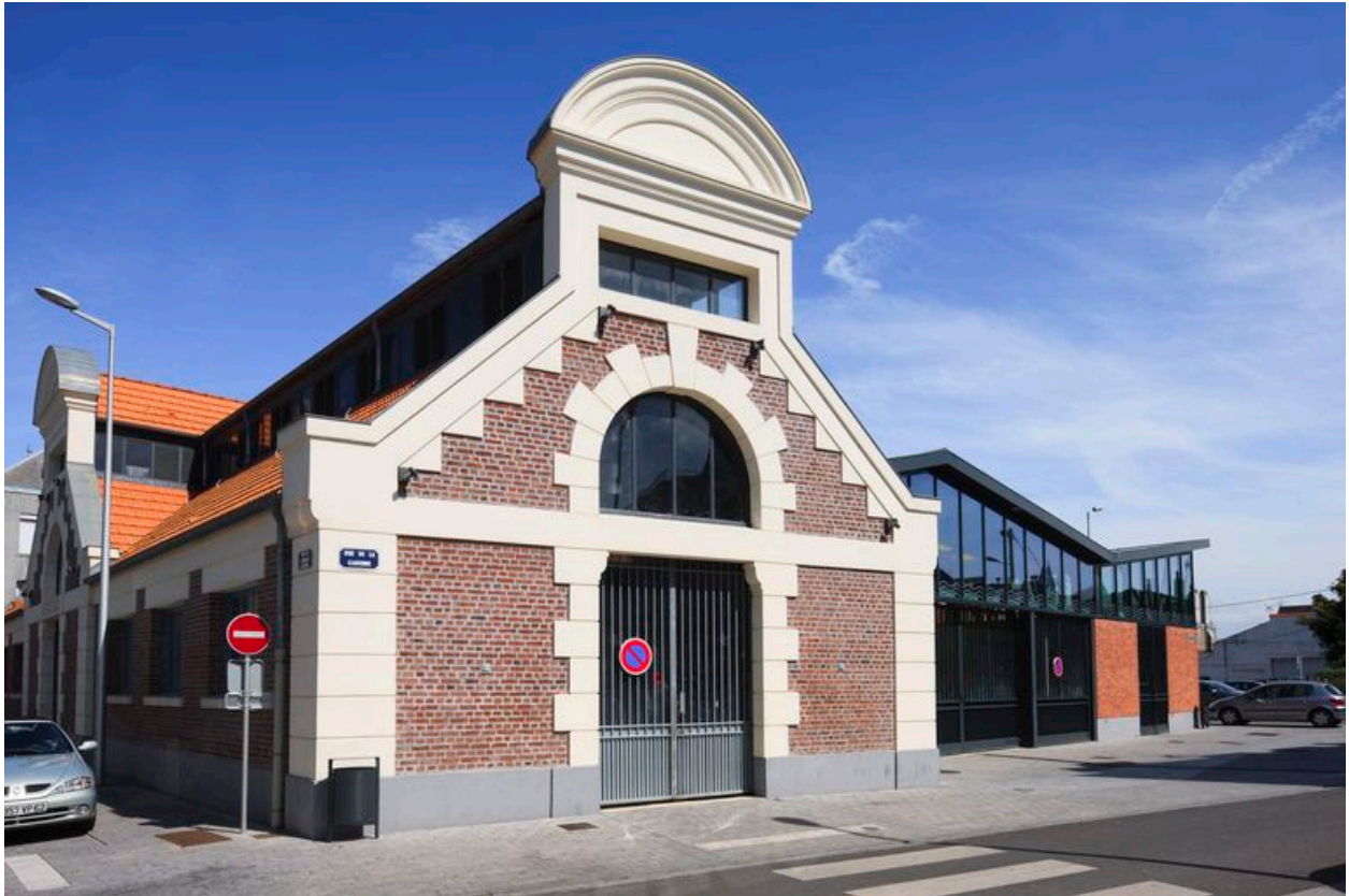
Vue générale de l'entrée ouest.
