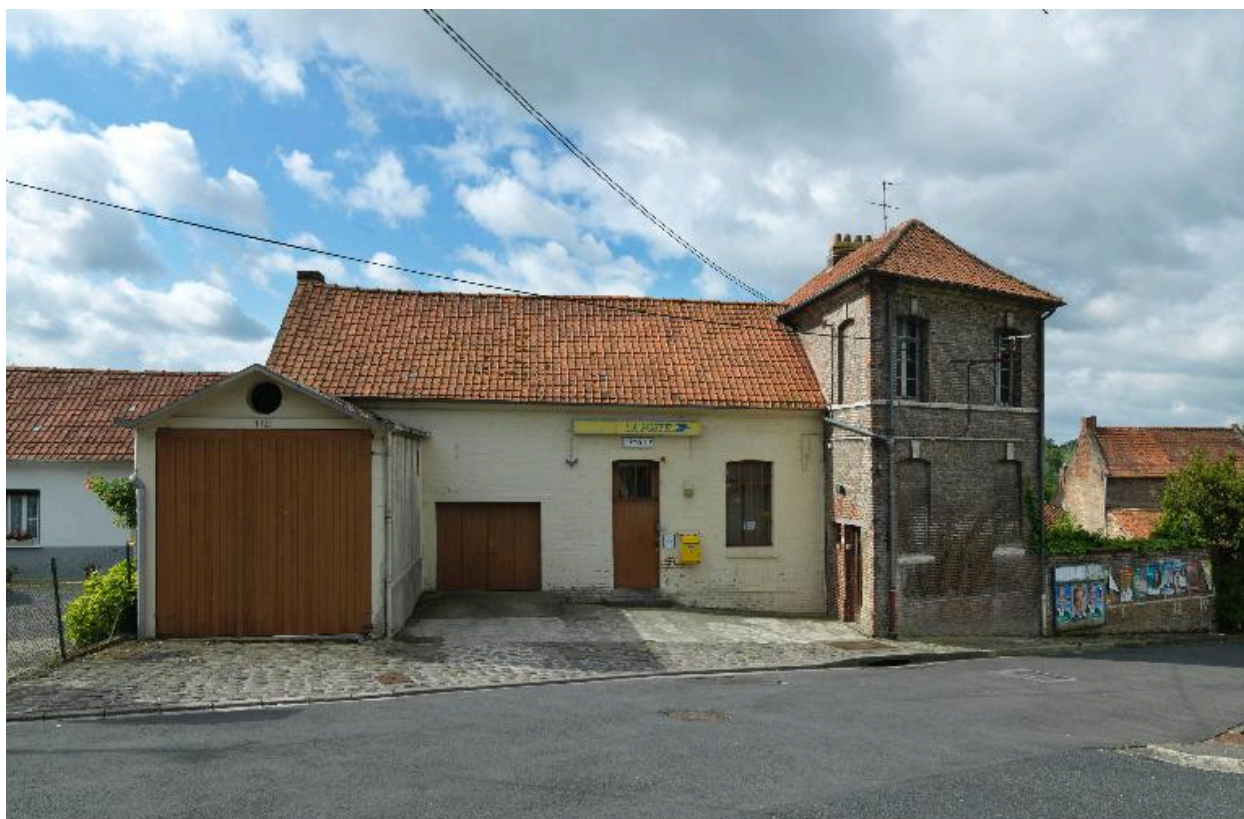
Vue d'ensemble sur rue.
