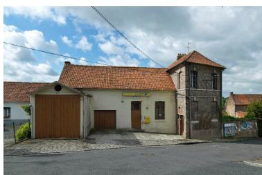
Vue d'ensemble sur rue. Phot. Thierry Lefébure IVR22_20128000329NUC2A
