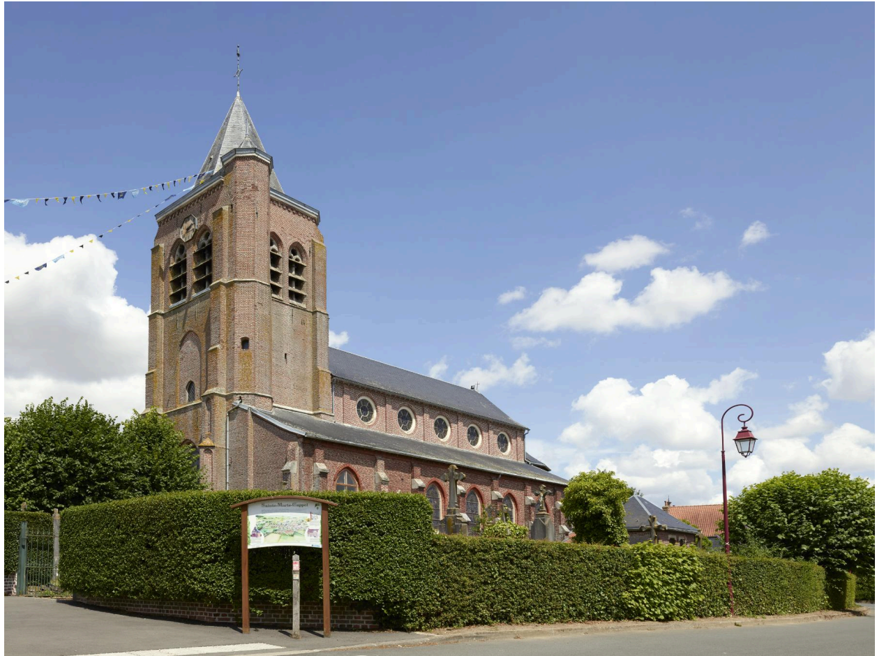
Vue depuis le sud-ouest.
