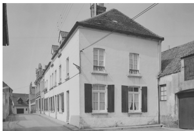
Vue de côté. Phot. Philippe Caudroit IVR31_19836200247X
