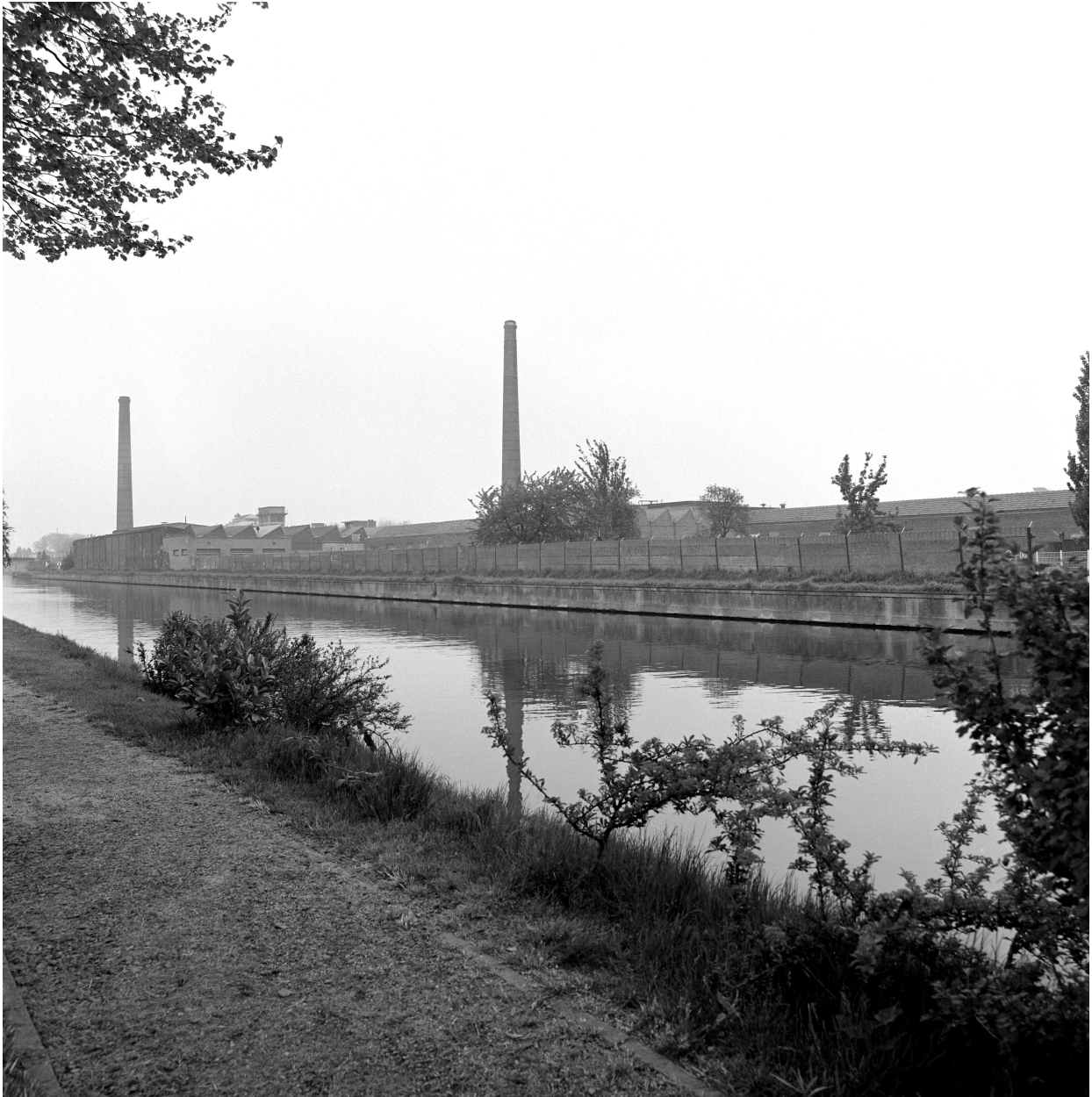
Vue générale vers le nord-ouest depuis la Lys.
