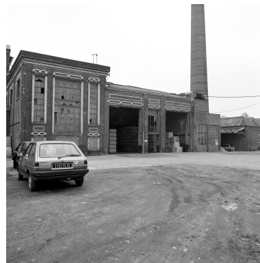
Ancienne salle des machines depuis la cour. Phot. Philippe Dapvril IVR31_19885900739X
