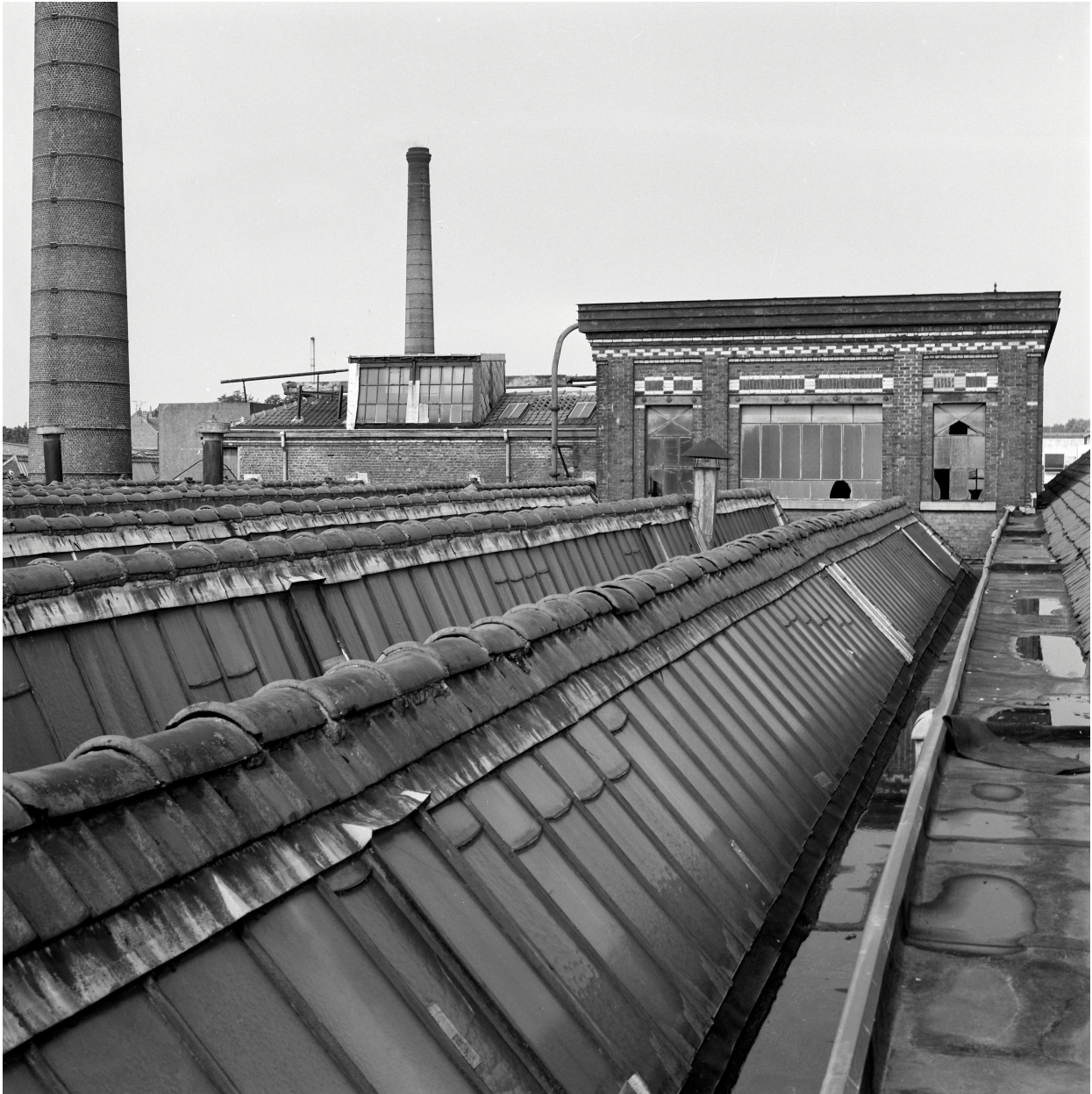
Ancienne salle des machines vue des toits.
