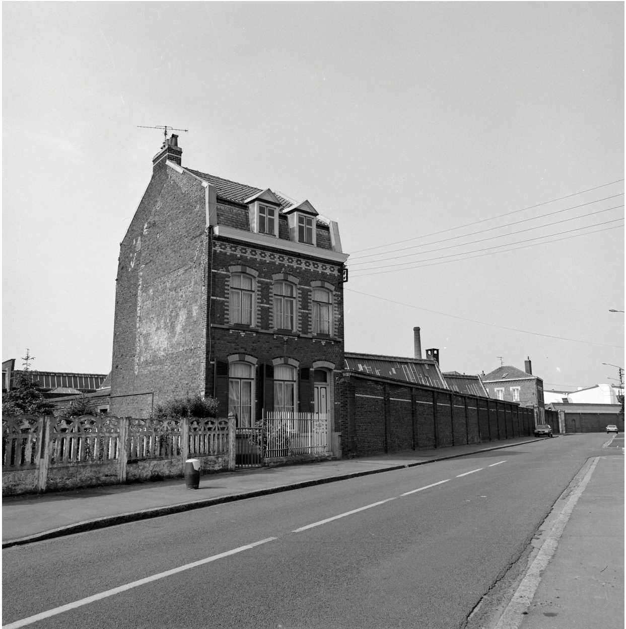
Vue générale vers l'ouest depuis la rue Léo-Lagrange.
