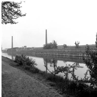
Vue générale vers le nord-ouest depuis la Lys. Phot. Philippe Dapvril IVR31_19885900742X
