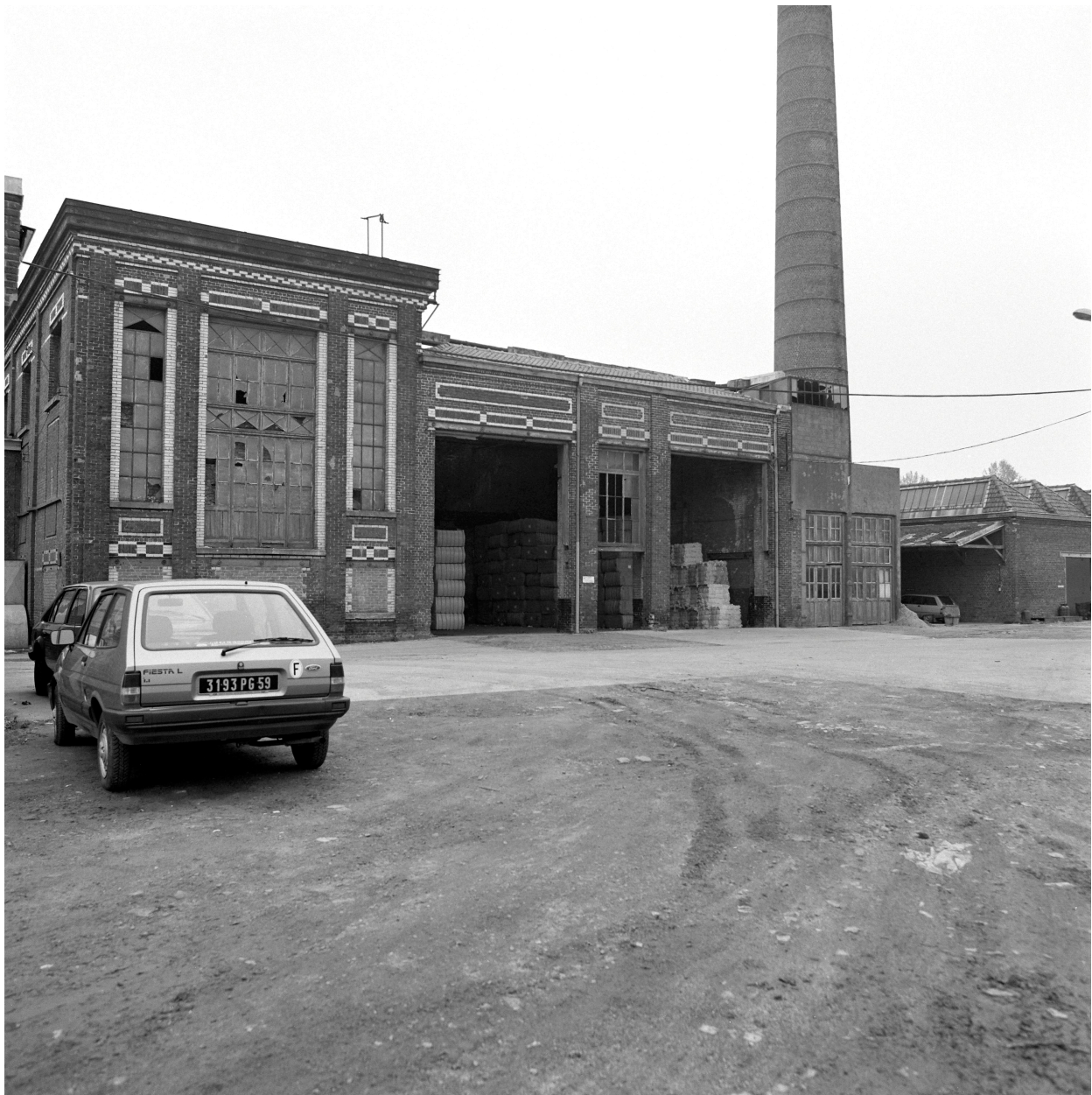
Ancienne salle des machines depuis la cour.
