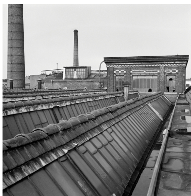
Ancienne salle des machines vue des toits. Phot. Philippe Dapvril IVR31_19885900885X
