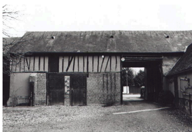
Les grange et l'entrée charretière sous porche, façade sur cour. Phot. Bertrand Fournier IVR22_20026000528Z
