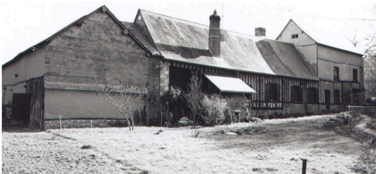
Vue d'ensemble postérieure du moulin et de son habitation.
