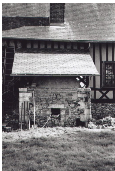
Détail du four à pain. Phot. Bertrand Fournier IVR22_20026000501Z
