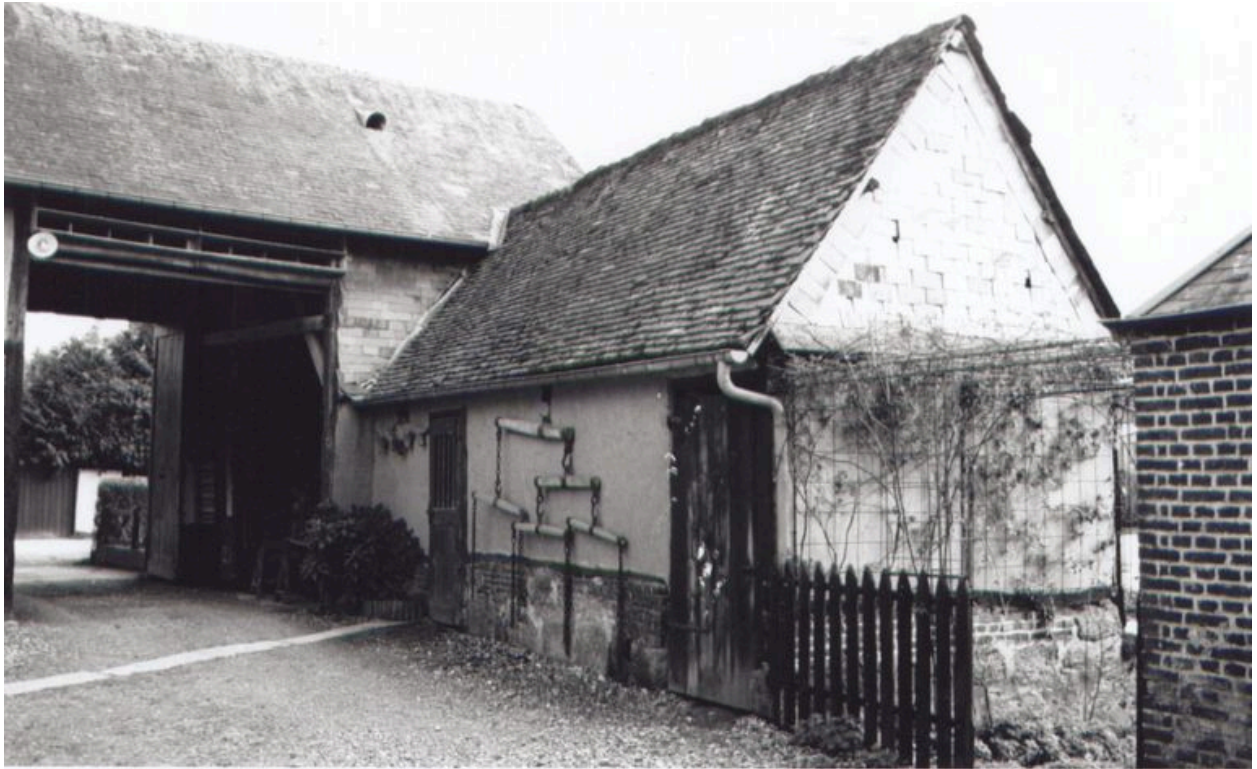
L'entrée charretière sous porche, façade sur cour.
