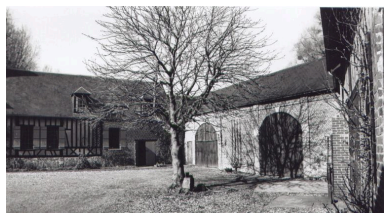
Vue de l'habitation et des granges en retour, façades sur cour. Phot. Bertrand Fournier IVR22_20026000524Z
