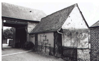
L'entrée charretière sous porche, façade sur cour. Phot. Bertrand Fournier IVR22_20026000529Z
