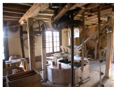
Intérieur du premier étage, vue d'ensemble avec l'une des deux meules sous son coffrage. Phot. Bertrand Fournier IVR22_20026000802NUCA
