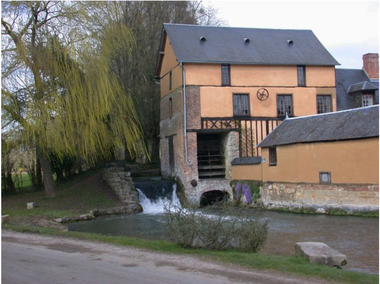
Ensemble extérieur du moulin et de sa roue sous cage.
