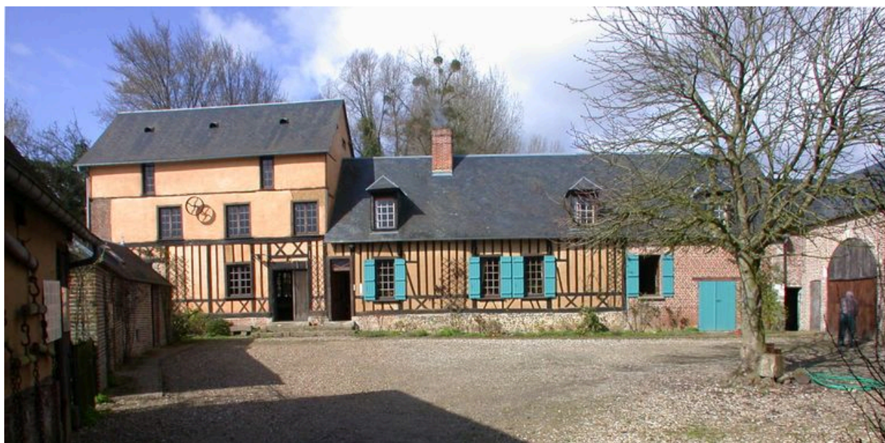
Vue d'ensemble sur cour du moulin et de son habitation.
