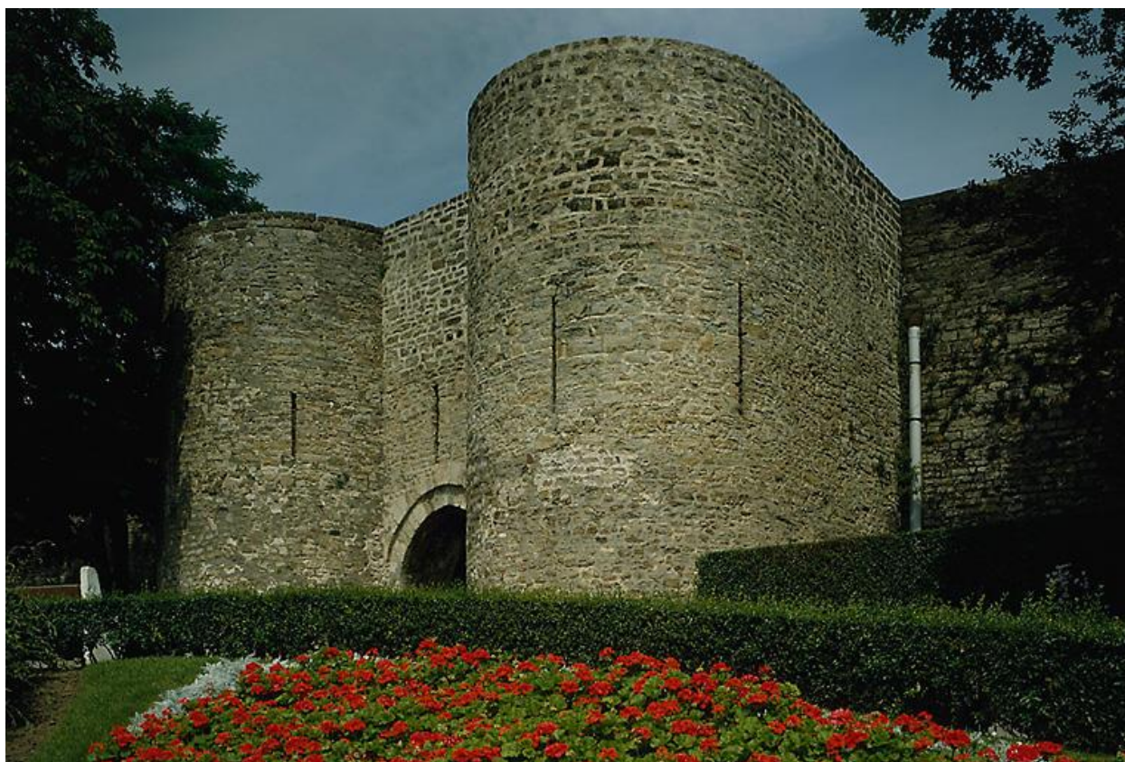
Façade ouest sur boulevard du Prince Albert Ier.
