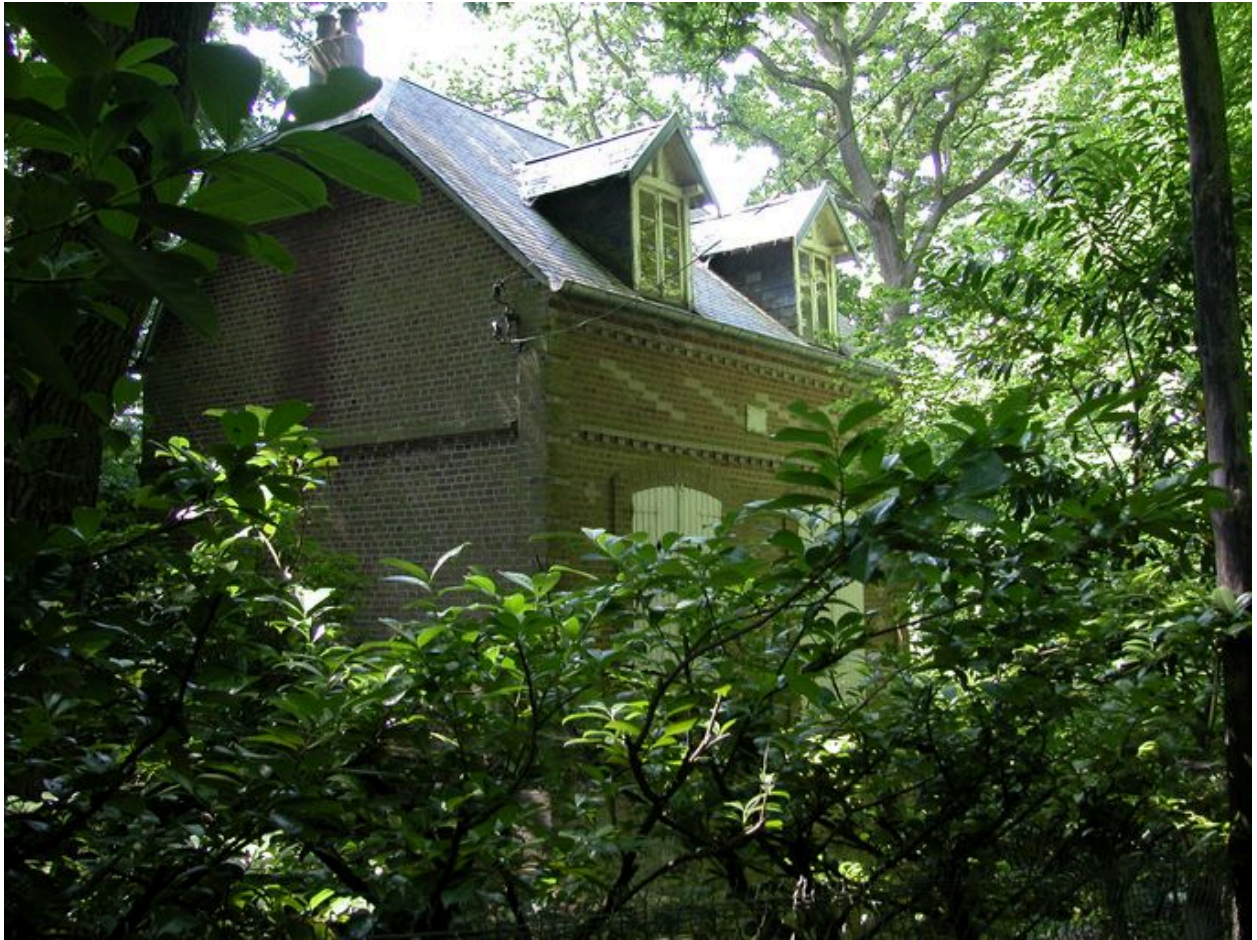
Vue d'ensemble, élévation ouest, depuis le sentier des Génêts.
