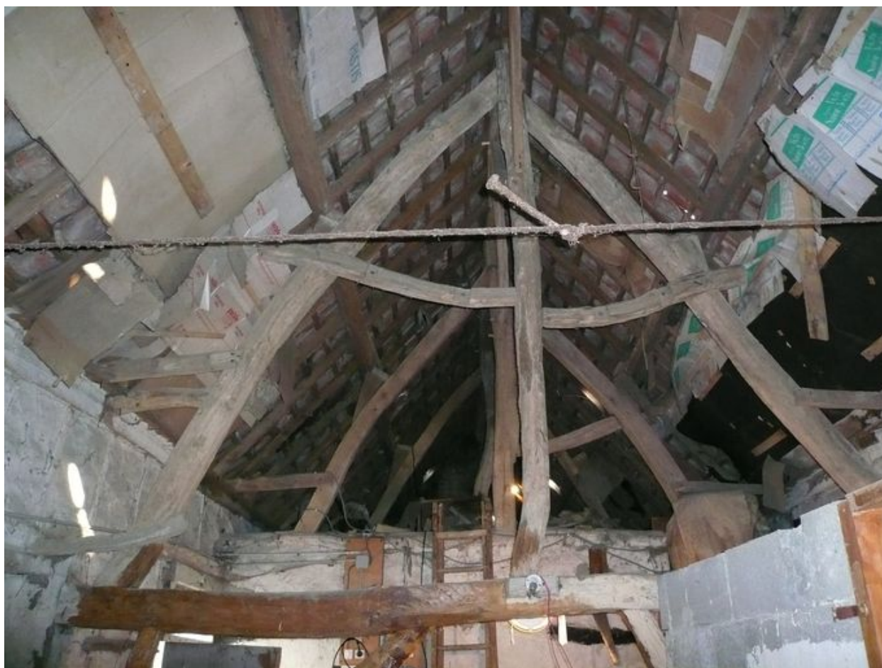
Vue de la charpente.
