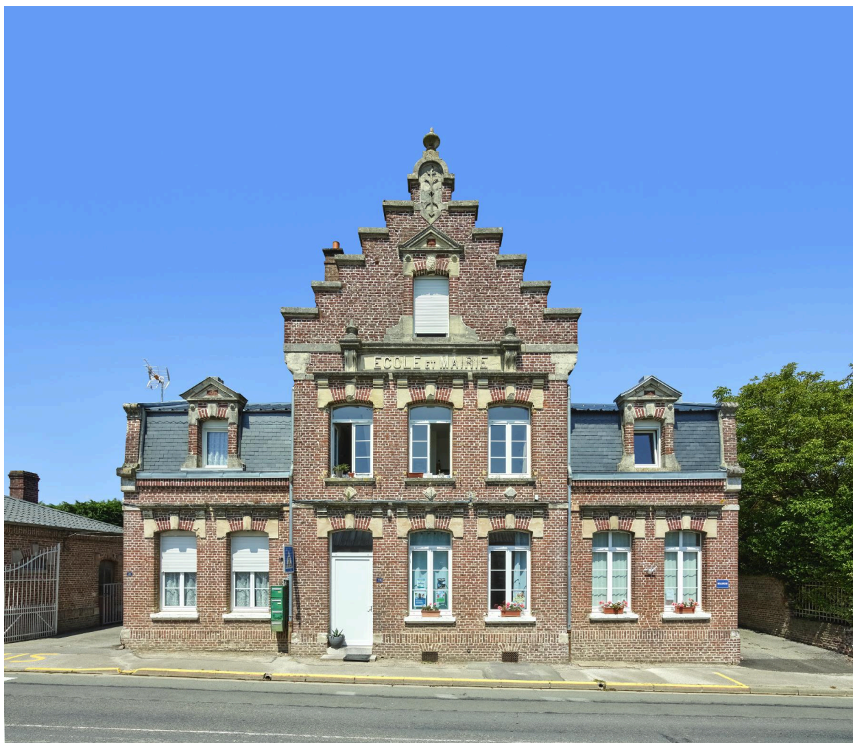
Mairie-école de la commune d'Arry, vue de face.
