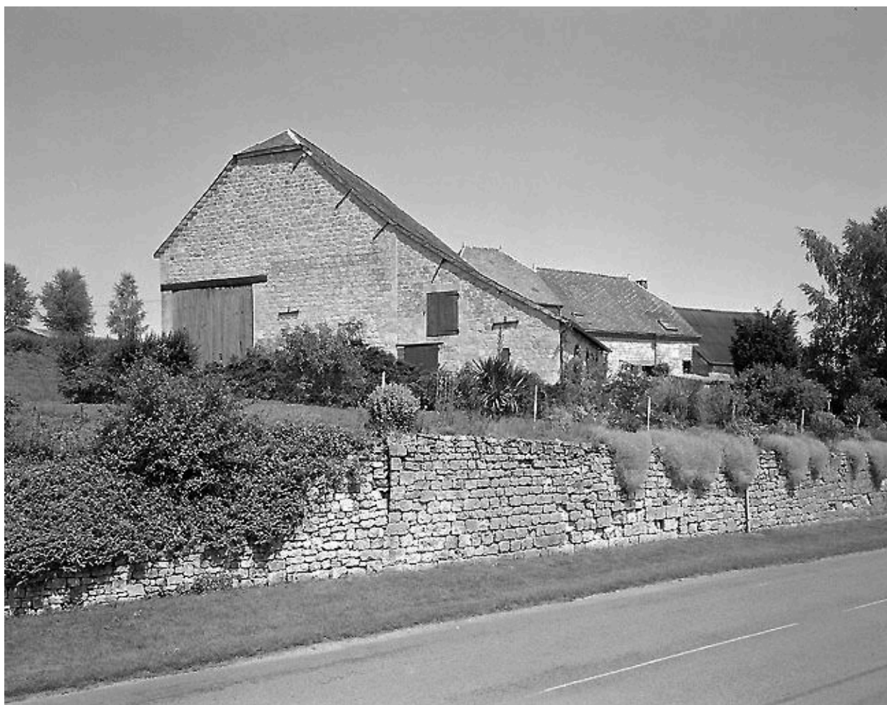
Vue générale depuis la route.
