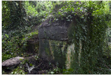
Pignon ouest Phot. Jean-Marc Ramette IVR31_20145904284NUCA
