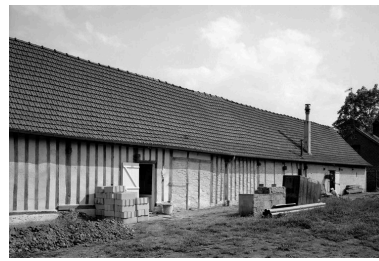
Elévation postérieure. Phot. Jean-Michel Perrin IVR22_19856000878X
