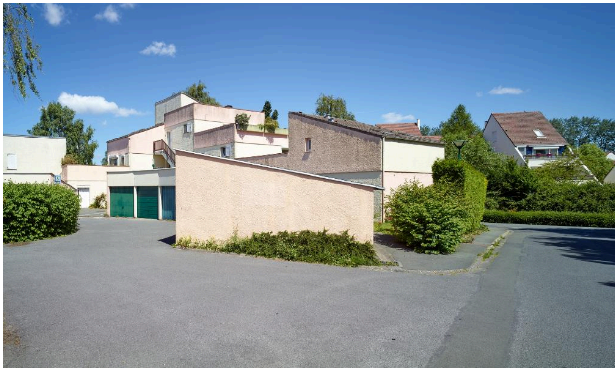
Le débouché de l'allée de la Chaîne sur la rue Charles-le-Bon (à droite) et l'entrée d'une première placette (à gauche).
