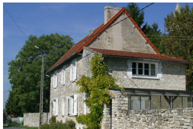
Vue générale. Phot. Inès Guérin IVR22_20030203285NUCA
