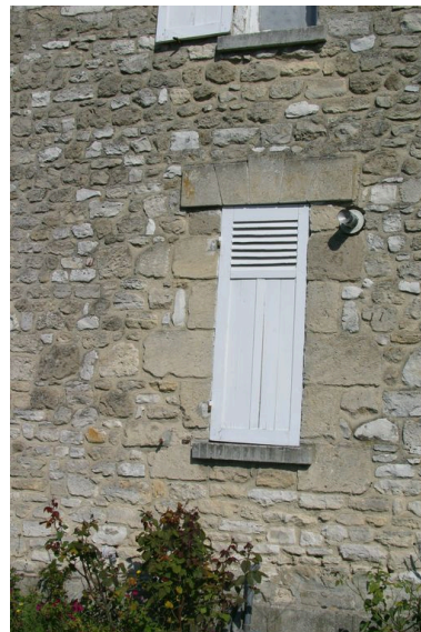
Détail du mur de façade. Phot. Inès Guérin IVR22_20030202003NUCA
