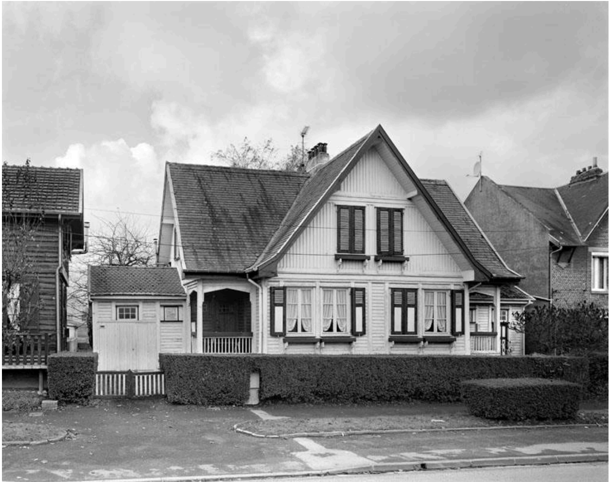
Vue de la façade sur rue.
