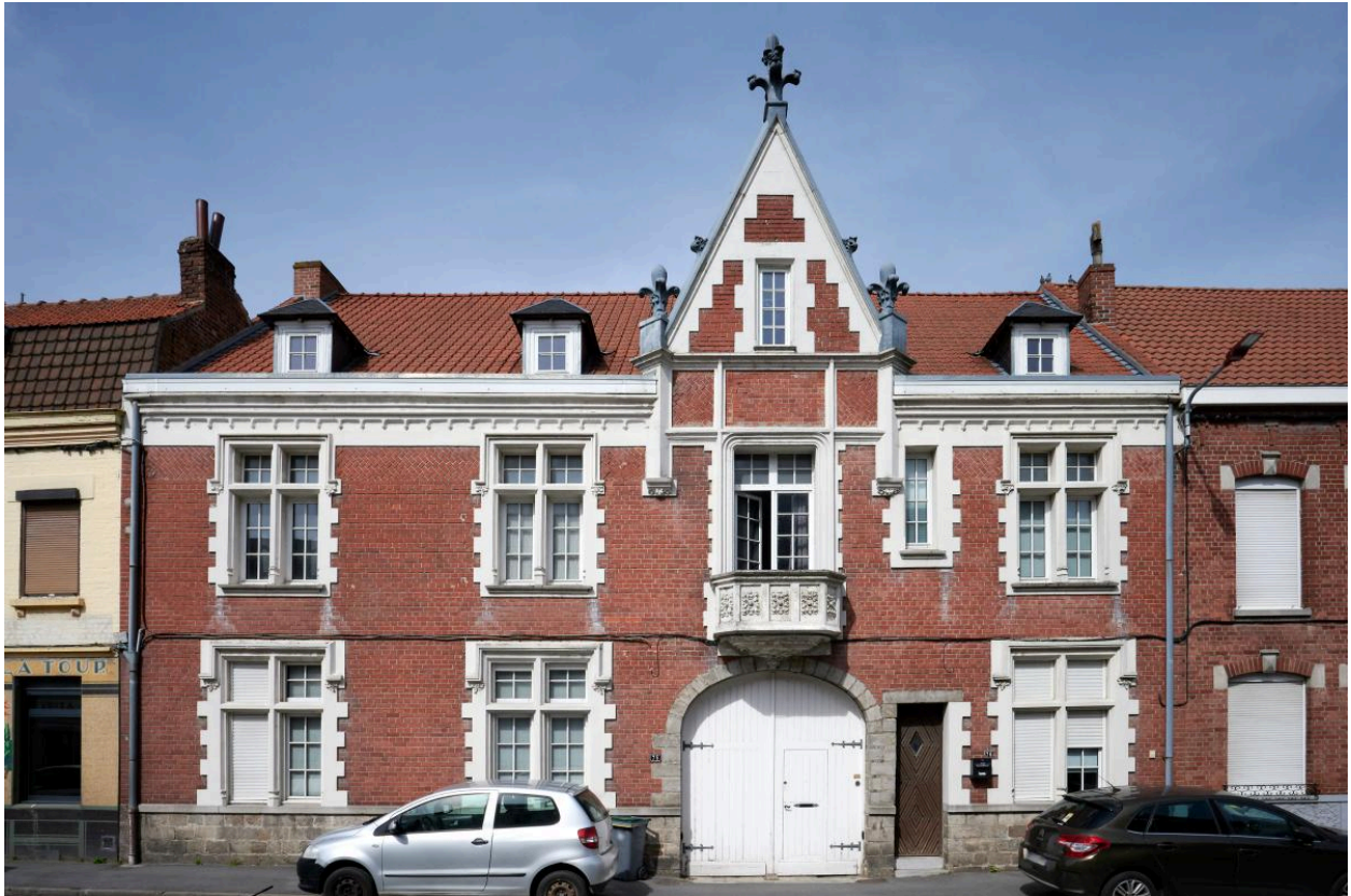
Élévation antérieure du logement rue Jules-Ferry.
