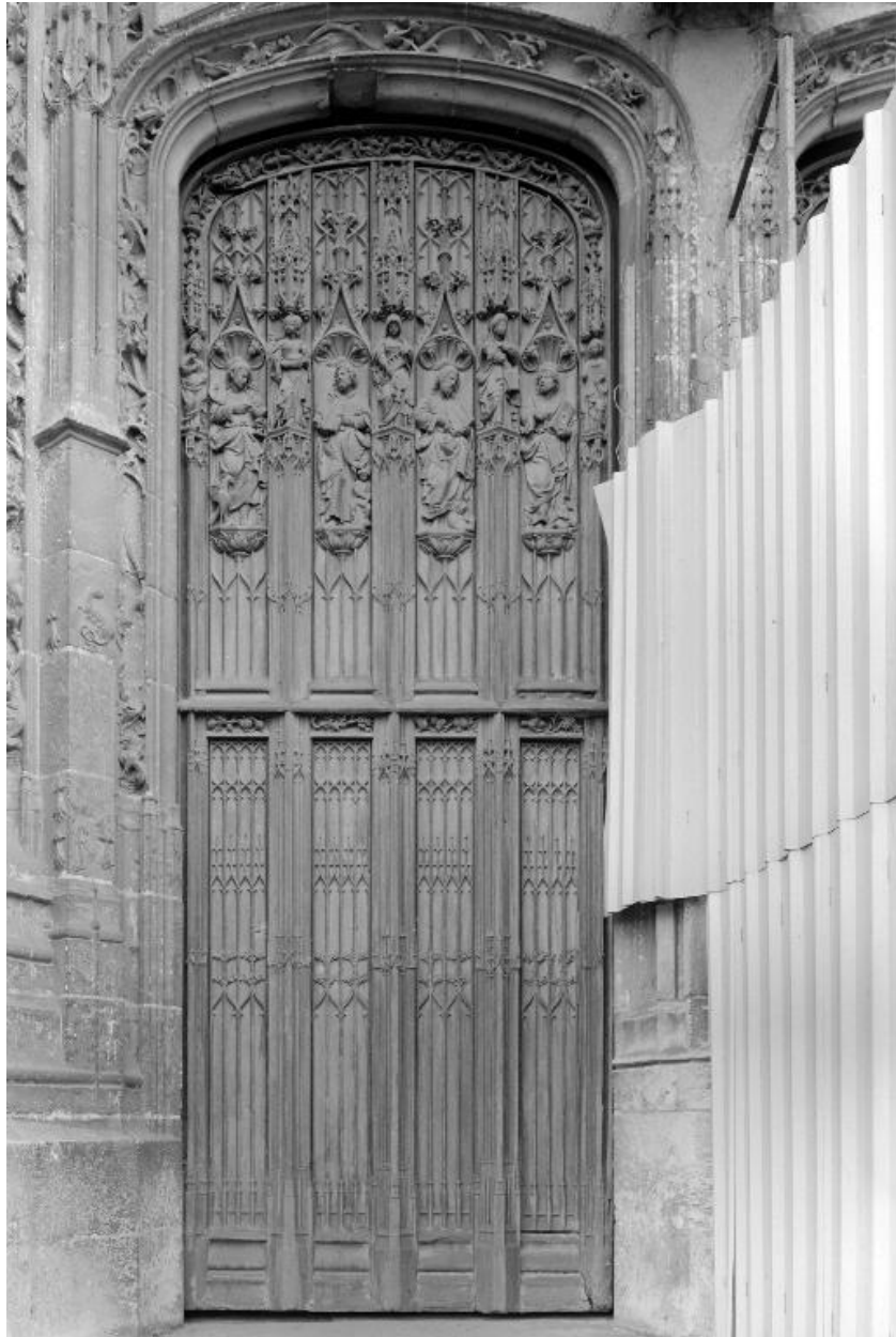
Vue du vantail gauche du portail nord.
