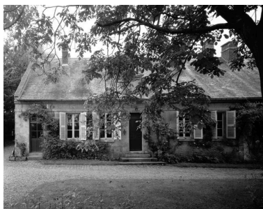
Élévation antérieure. Phot. Jean-Michel Perrin IVR22_19846001114V
