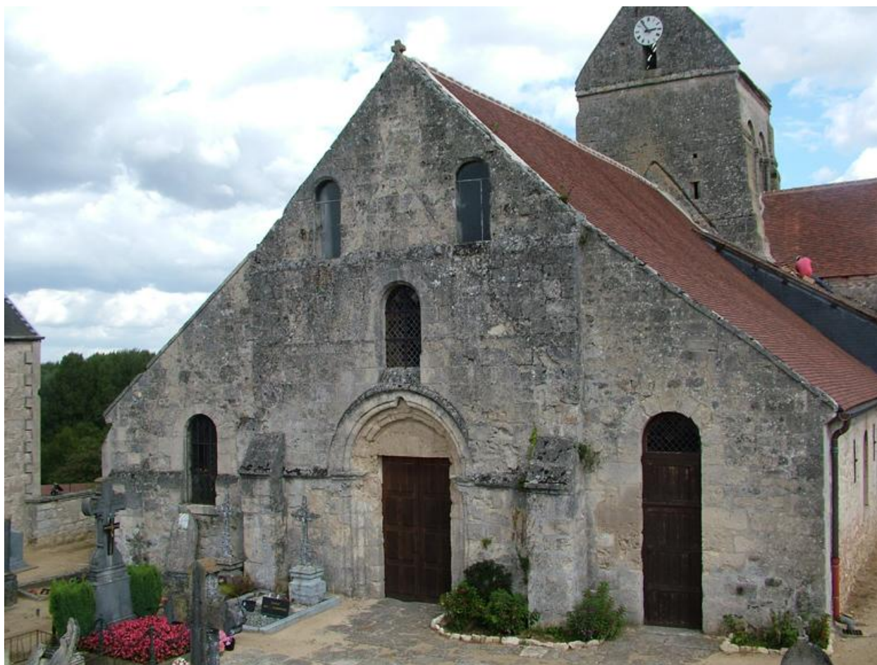
Vue générale de l'élévation occidentale.
