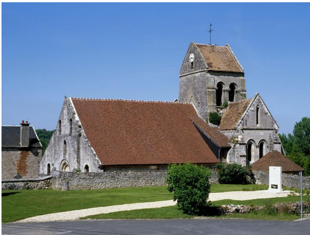
Vue générale, depuis le sud-ouest.
