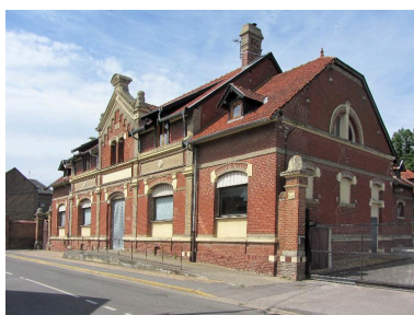
Façade sur rue, vue des trois quarts. Phot. Bertrand Fournier IVR22_20138015948NUC2A
