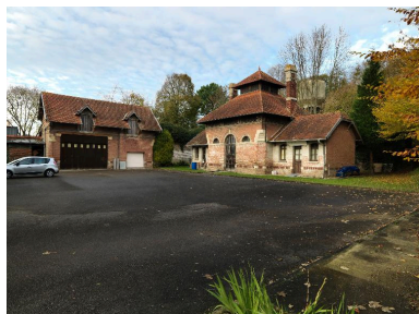
Vue d'ensemble des bâtiments sur cour. Phot. Thierry Lefébure IVR22_20138000502NUC2A
