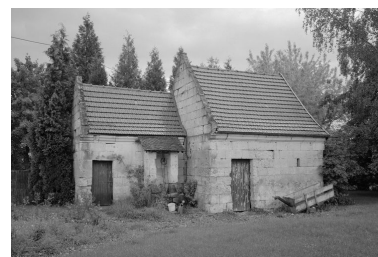
Remise et puits. Phot. Jean-Michel Périn IVR22_19856000753X
