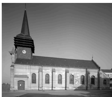
Elévation sud. Phot. Jean-Michel Périn IVR22_19846001317V
