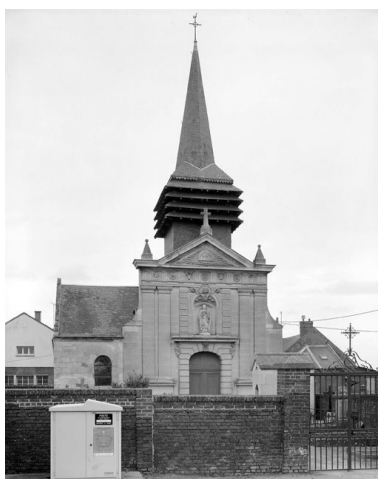
Elévation occidentale. Phot. Jean-Michel Périn IVR22_19846001468V
