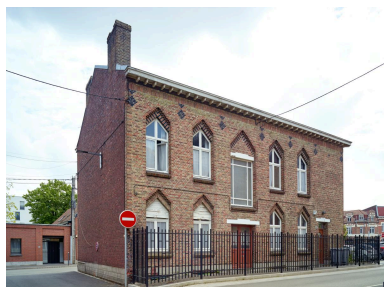
Vue d'ensemble de la façade nord, depuis le nord-est.
