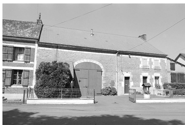
Vue générale. Phot. Xavier-Philippe Guiochon IVR22_19980202730Z
