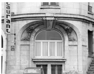
Pan coupé, rez-de-chaussée, fenêtre. Phot. Philippe Caudroit IVR31_19816203548X
