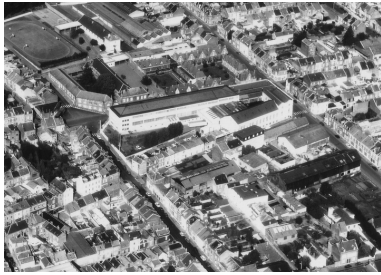
Vue aérienne de l'usine en 1989, prise du sud. Phot. Pillet Frédéric, Autr. Phot'R IVR22_20040200591NUCA
