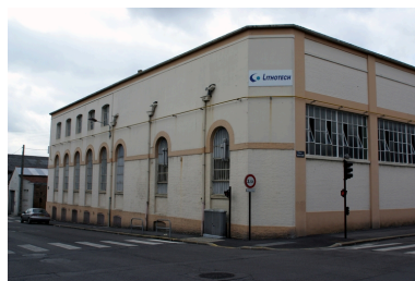
Façade des ateliers, à l'angle des rues de Mulhouse et Quentin-Barré. Phot. Frédéric Pillet IVR22_20040200728NUCA
