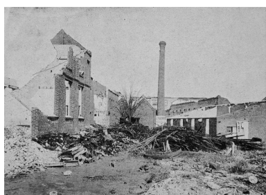
Photographie des ateliers en ruine en 1919 : au centre, la cheminée d'usine, et les bâtiments de générateurs et de la salle des machines. A gauche, les ateliers bordant la rue Quentin-Barré (Le Monde Illustré). Phot. Pillet Frédéric IVR22_20040200587NUCAB
