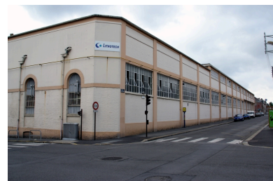
Façade des ateliers reconstruits après la Première Guerre mondiale, rue Quentin-Barré. Phot. Frédéric Pillet IVR22_20040200729NUCA
