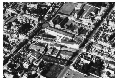
Vue aérienne de l'usine en 1989, prise de l'est sud-est. Phot. Pillet Frédéric, Autr. Phot'R IVR22_20040200590NUCA
