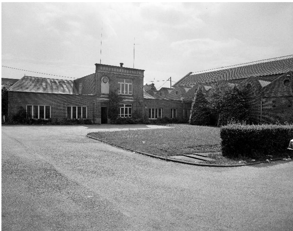
Bureau, flanc nord.
