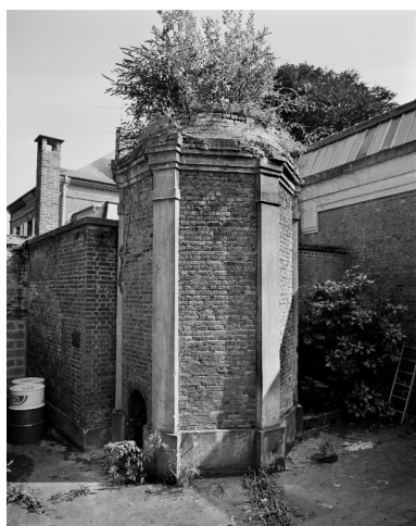
Cheminée d'usine, socle. Phot. Thierry Lefébure IVR22_19888000809V
