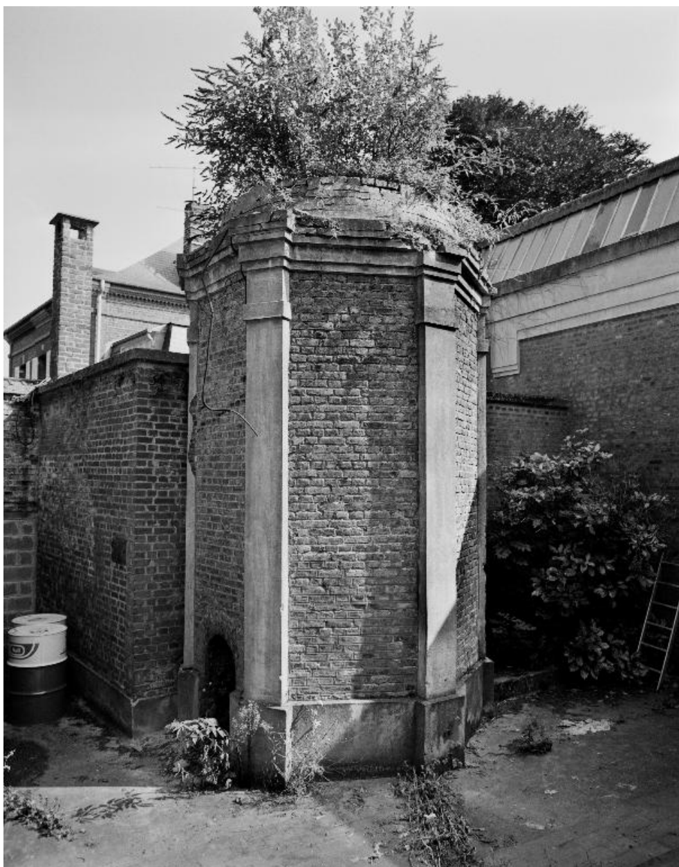
Cheminée d'usine, socle.
