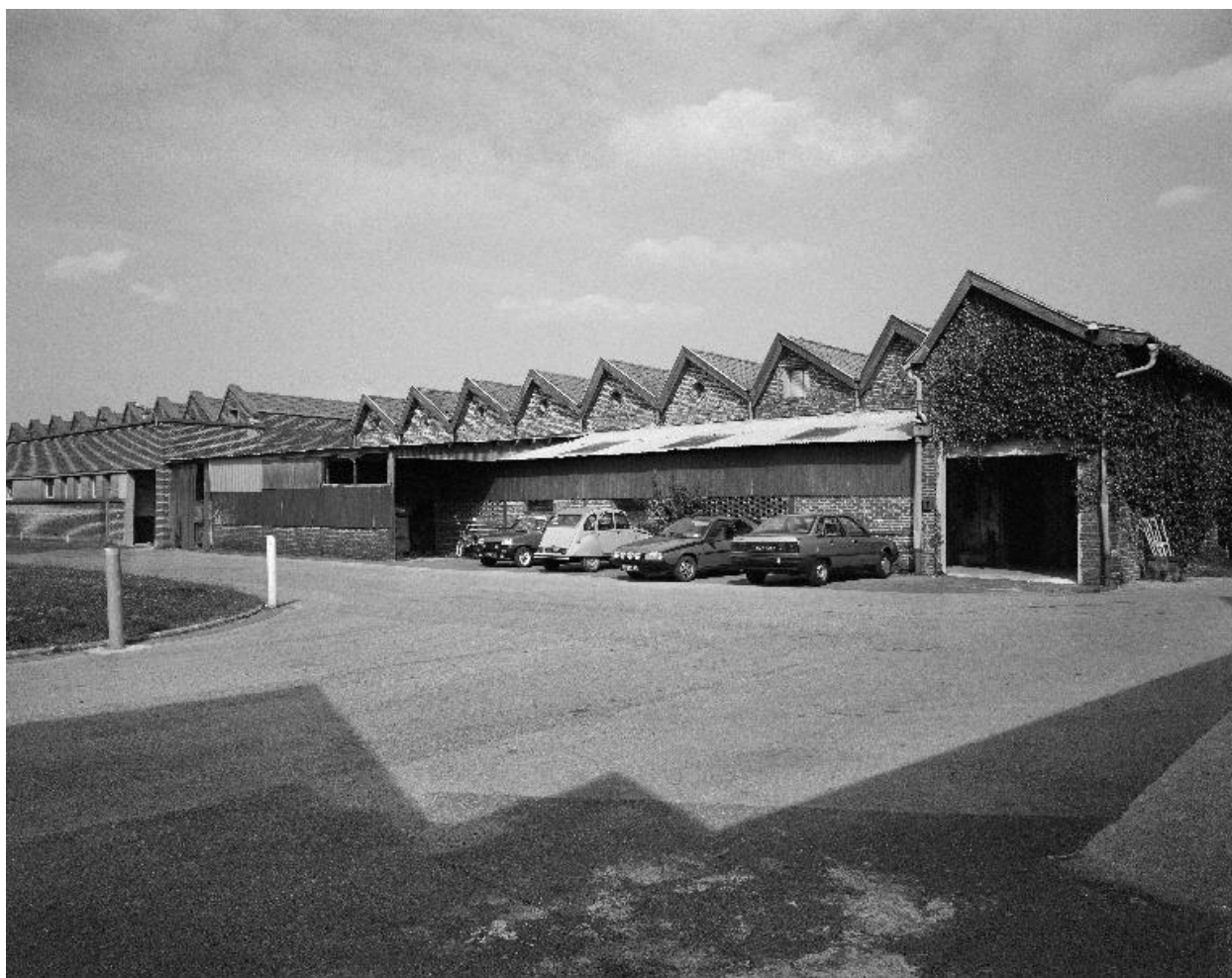
Atelier de fabrication, flanc ouest.
