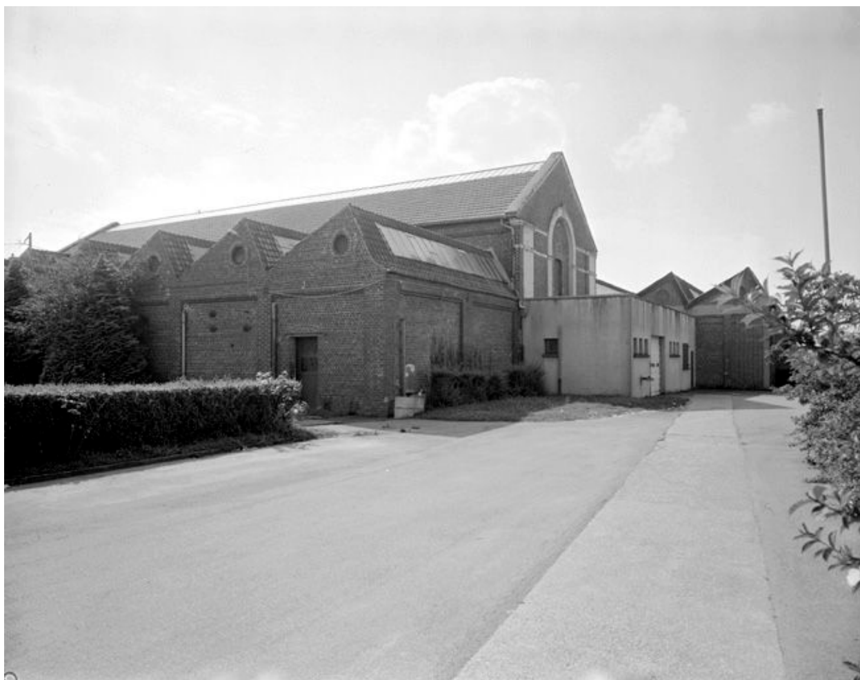
Corps du bâtiment C, flanc nord.
