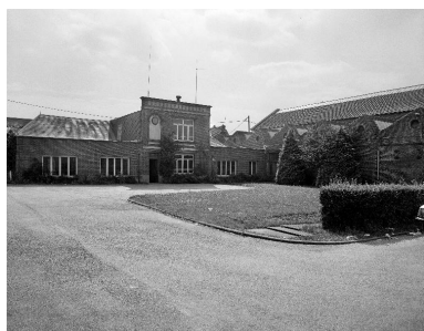
Bureau, flanc nord. Phot. Thierry Lefébure IVR22_19888000818V
