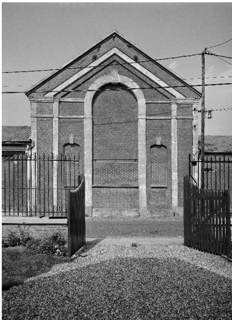
Corps de bâtiment C, flanc sud.
