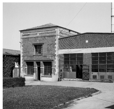
Chaufferies 1 et 2. Phot. Thierry Lefébure IVR22_19888000807V
