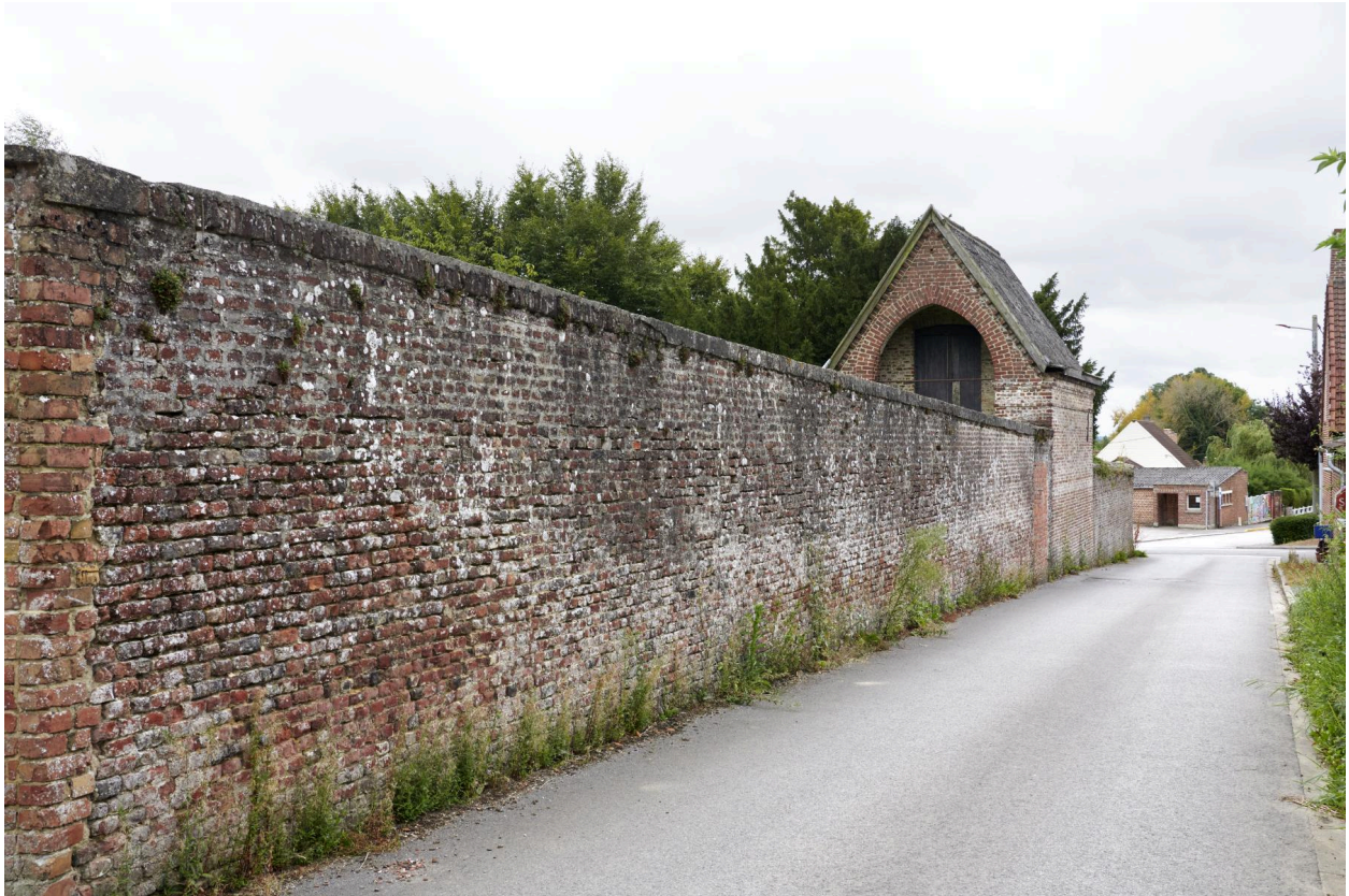
Ancien mur de clôture en brique. Rue des Montagnards depuis le nord.
