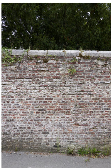
Détail de l'ancien mur de clôture en brique du domaine. Rue des Montagnards. Phot. Delphine Volto Jourdan IVR32_20245902900NUCA
