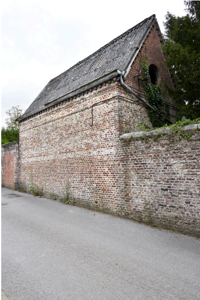
Ancien bâtiment 'écurie ?) intégré au mur de clôture en brique du domaine. Rue des Montagnards depuis le sud.
