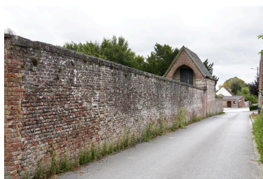
Ancien mur de clôture en brique. Rue des Montagnards depuis le nord. Phot. Delphine Volto Jourdan IVR32_20245902902NUCA
