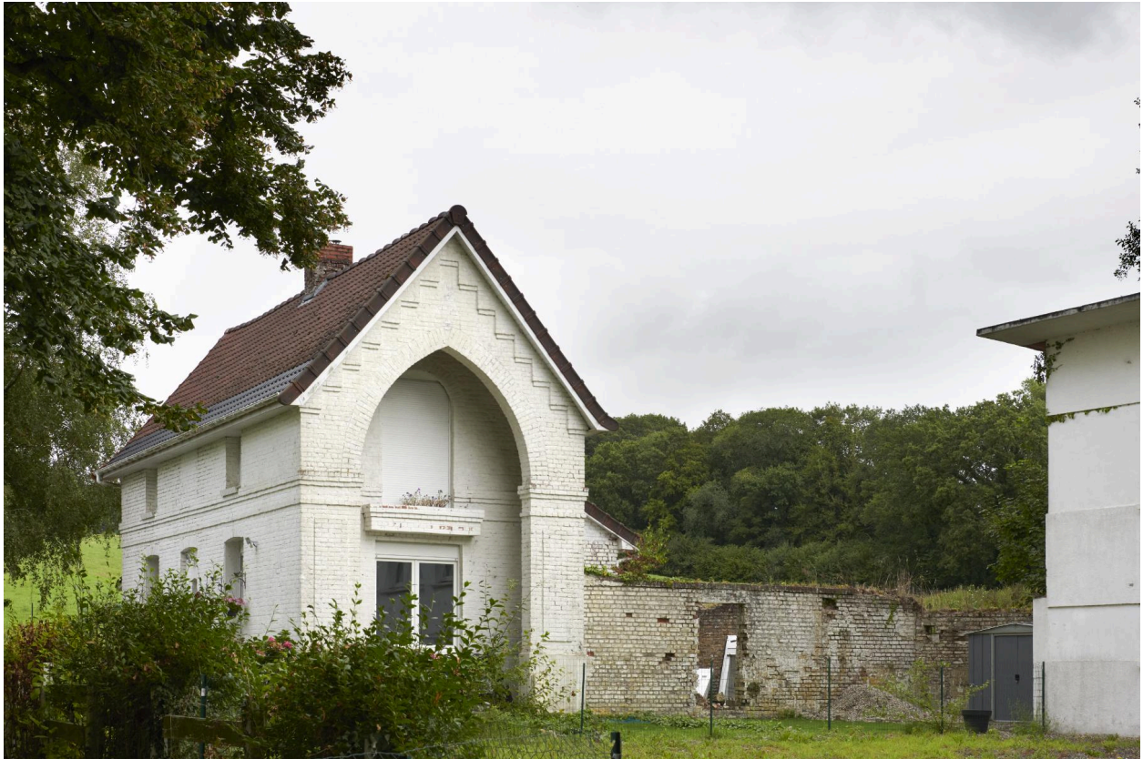
Ancien pavillon avec écurie et remise, puis gîte rural, actuellement habitation privée, situé au nord-est de l'ancien domaine.
