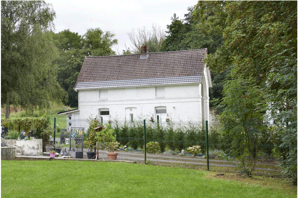
Ancien pavillon avec écurie et remise, puis gîte rural, actuellement habitation privée, situé au nord-est de l'ancien domaine. Côté ouest.
