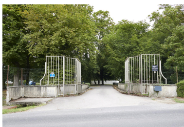
Grille d'entrée vers le domaine. Phot. Delphine Volto Jourdan IVR32_20245902894NUCA
