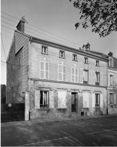
Elévation sur la rue. Phot. Thierry Lefébure IVR22_19940201139V
