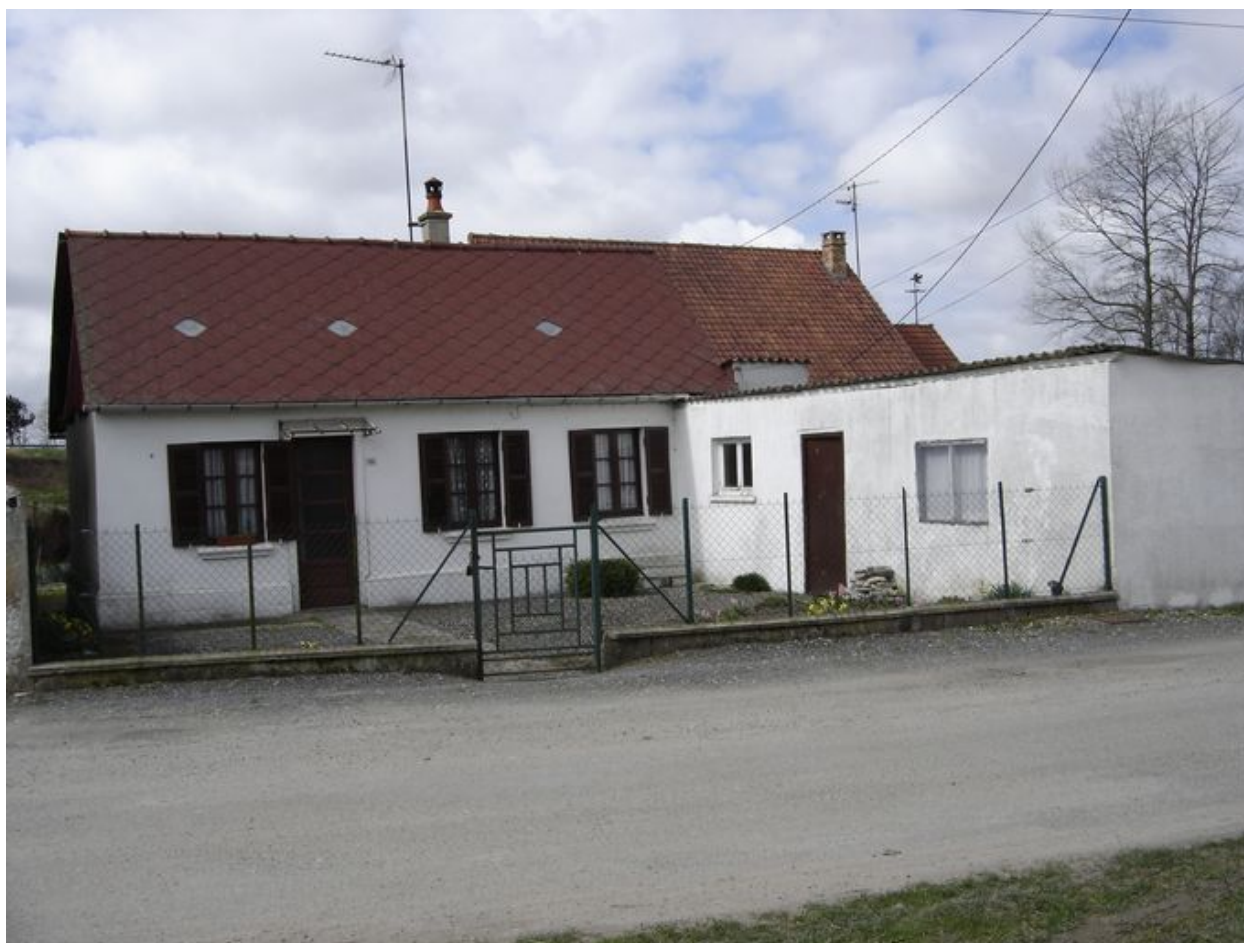
Vue générale du 18 Chemin de Valois.
