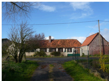
Vue générale. Phot. Inès Guérin IVR22_20078005558NUCA
