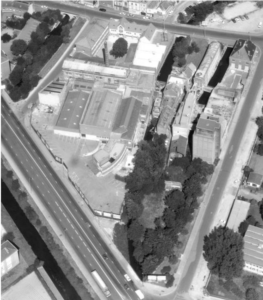
Vue aérienne depuis l'ouest.
