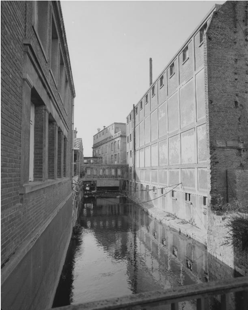
Ateliers de fabrication, vue partielle, flanc sud.
