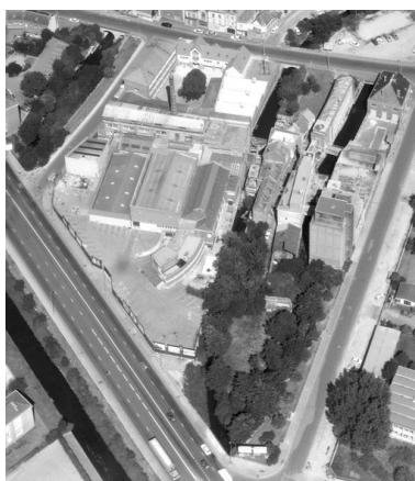
Vue aérienne depuis l'ouest.
