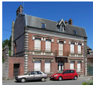
Façade sur rue, vue d'ensemble. Phot. Bertrand Fournier IVR22_20138015690NUCA
