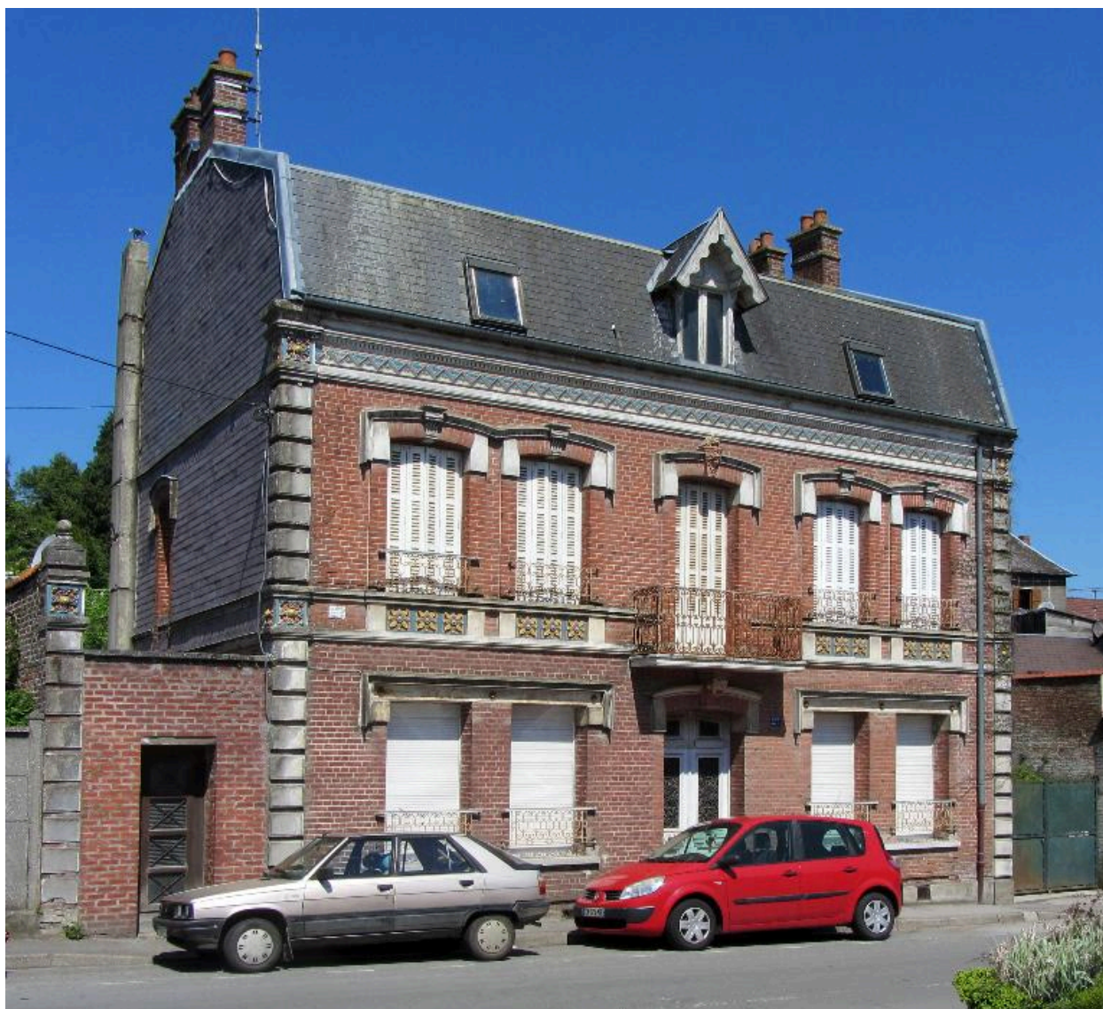
Façade sur rue, vue d'ensemble.
