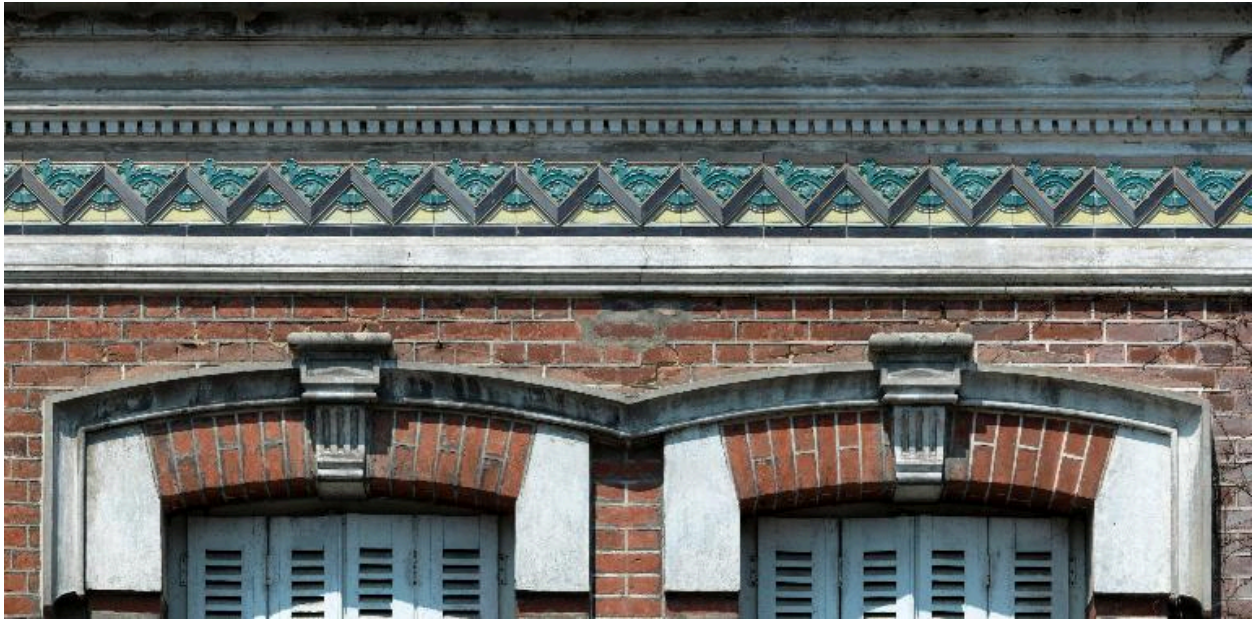
Détail des linteaux de fenêtres et de la frise en céramique architecturale.
