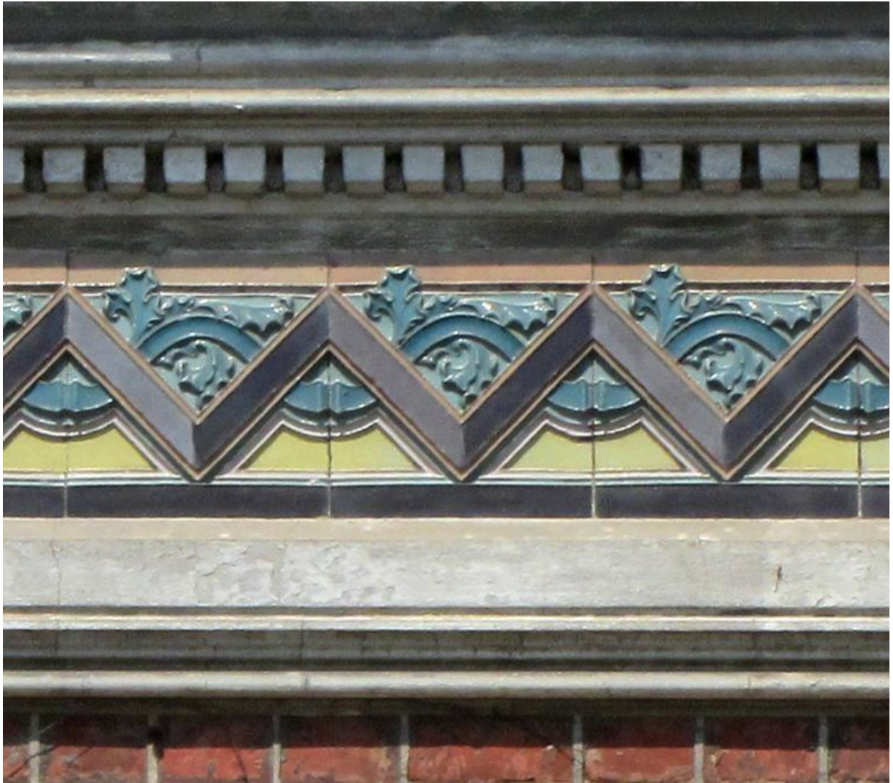
Détail de la frise de la corniche.
