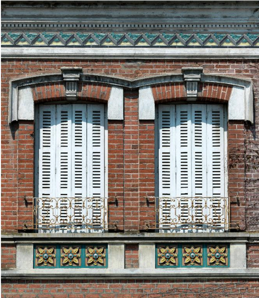
Détail des baies jumelles du premier étage.
