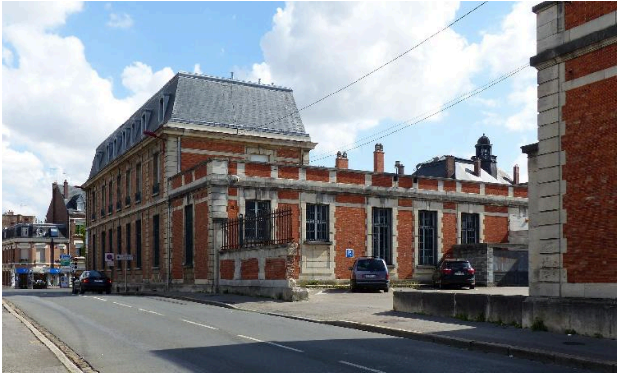
Vue générale, depuis la rue de la Caisse d'Epargne.
