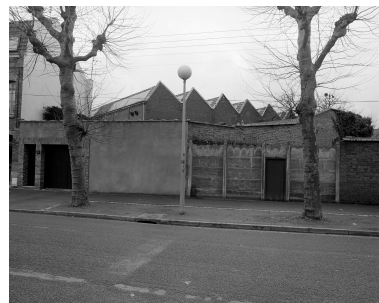
Atelier de fabrication. Vue prise vers le sud-est. Phot. Philippe Dapvril IVR31_19885902360X
