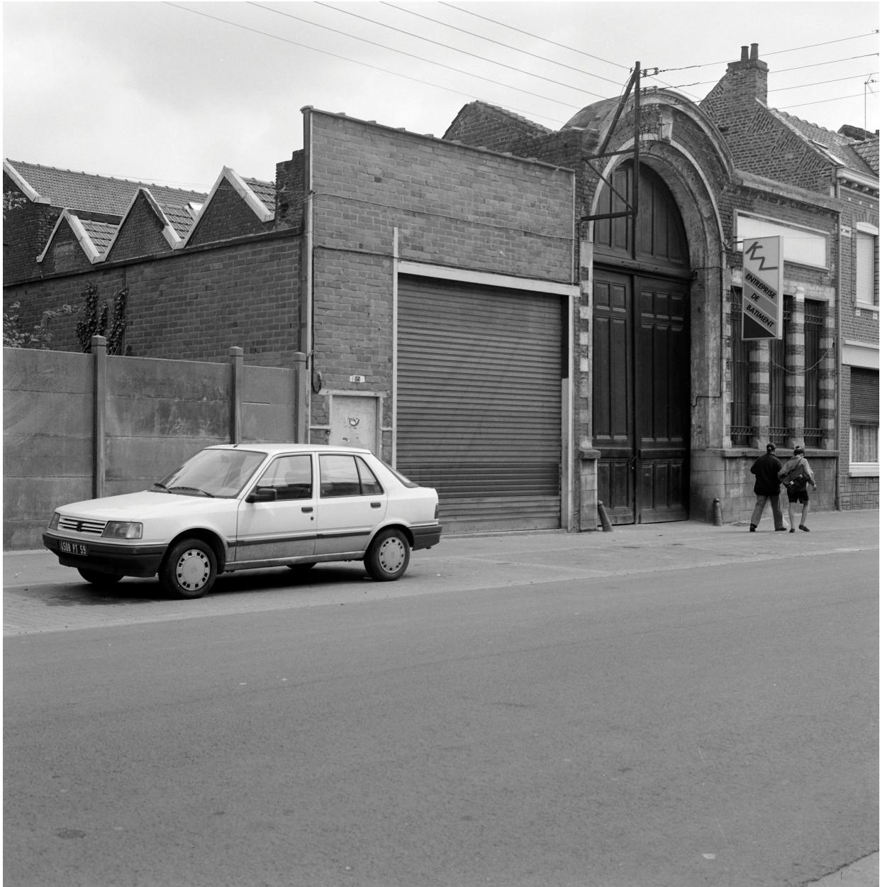
Élévation postérieure rue Jules-Ferry.
