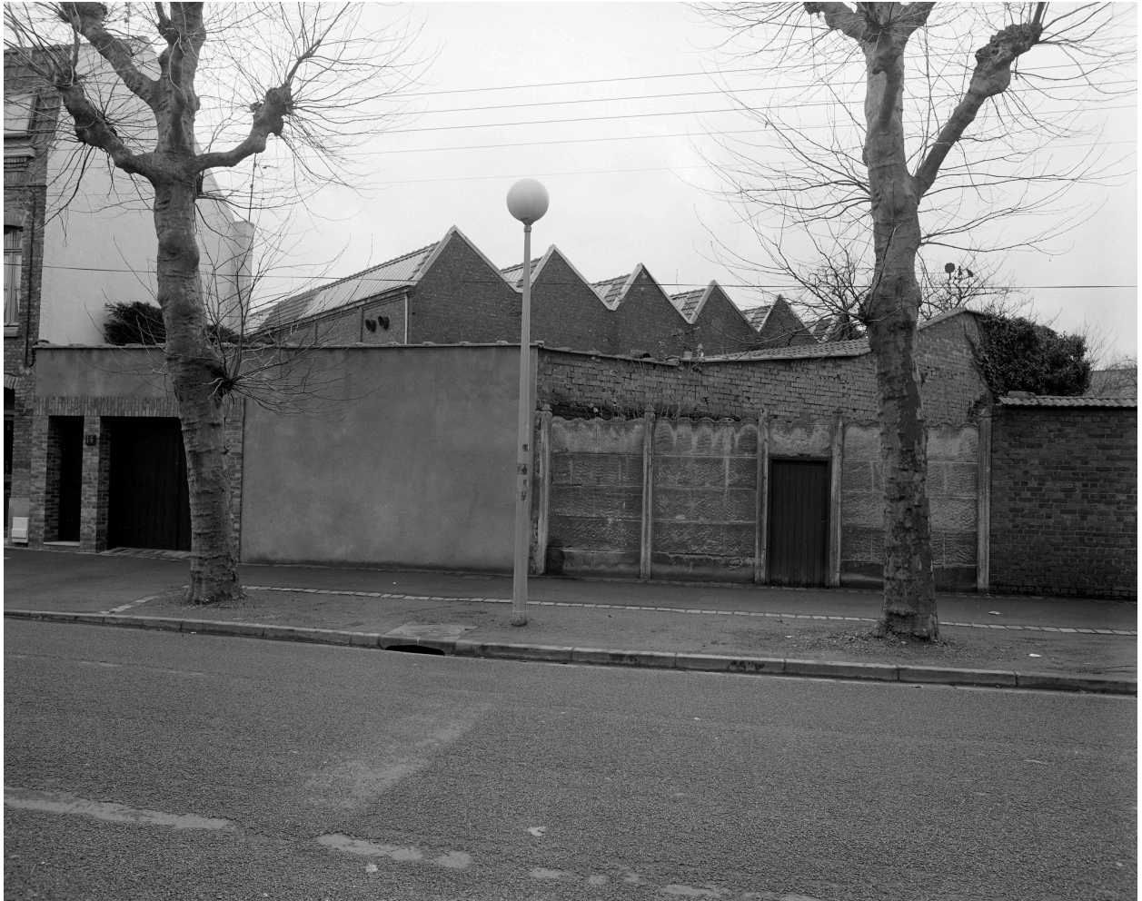
Atelier de fabrication. Vue prise vers le sud-est.
