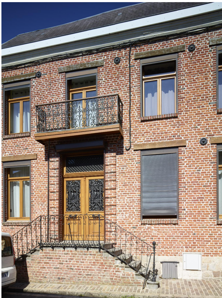
Détail de l'escalier droit en pierre bleue à volée double et mur d'échiffre en brique
