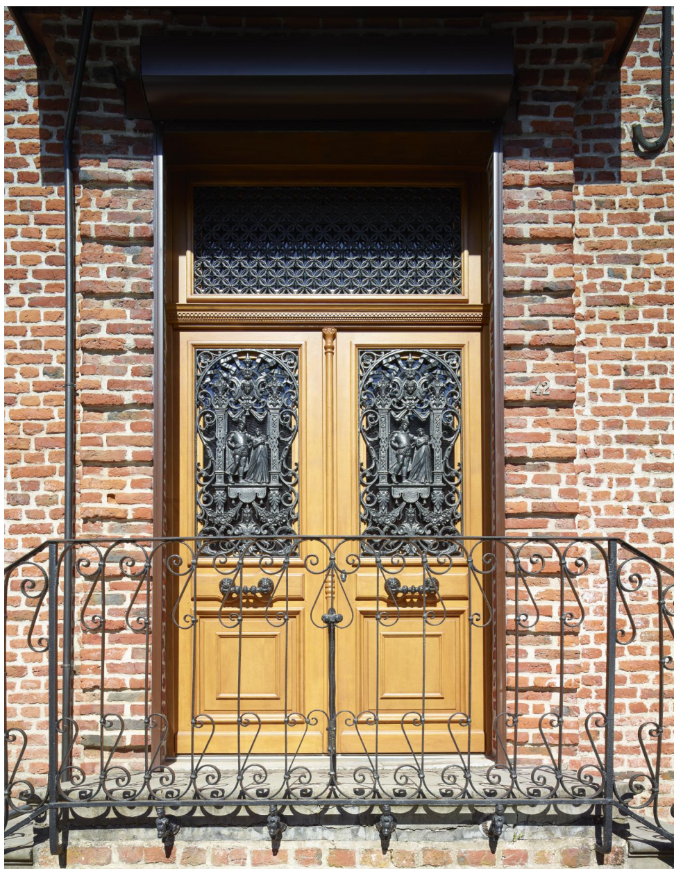
Détail des décors en fonte de la grille de protection la porte principale.
