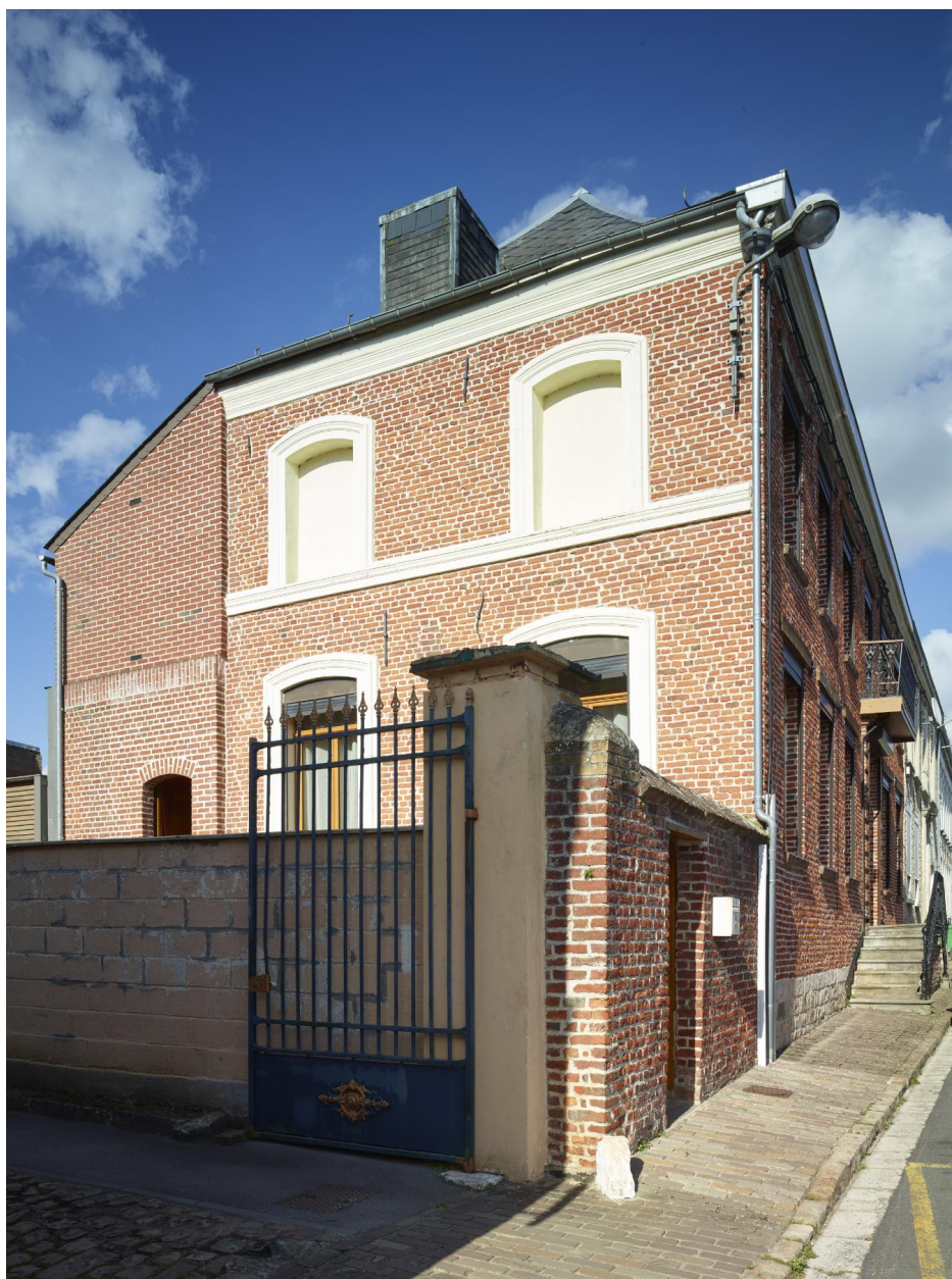
Ancien logis patronal de brasserie, actuellement maison de maître : façade latérale.
