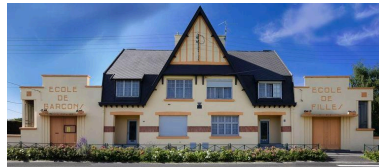
Vue générale de face. Phot. Hubert Bouvet IVR31_20105900332NUCA
