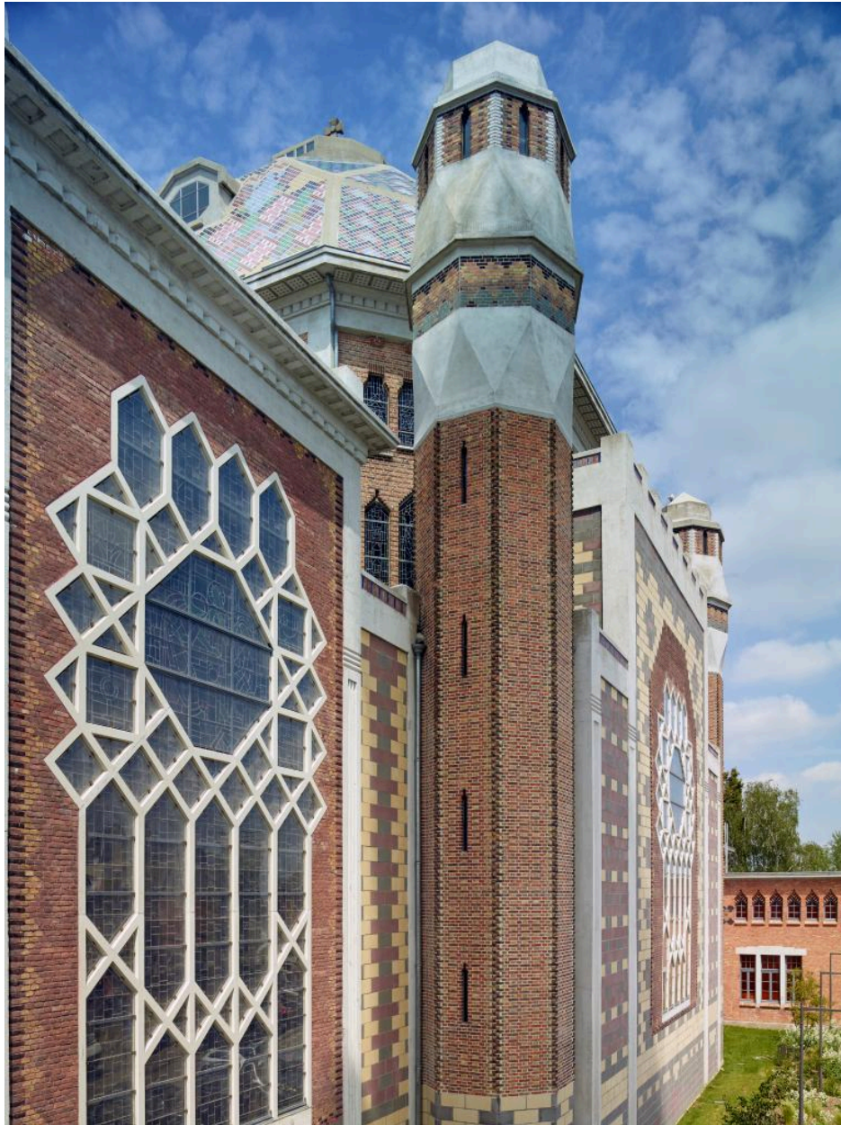
Façade sud du transept prise depuis le clocher de l'église.
