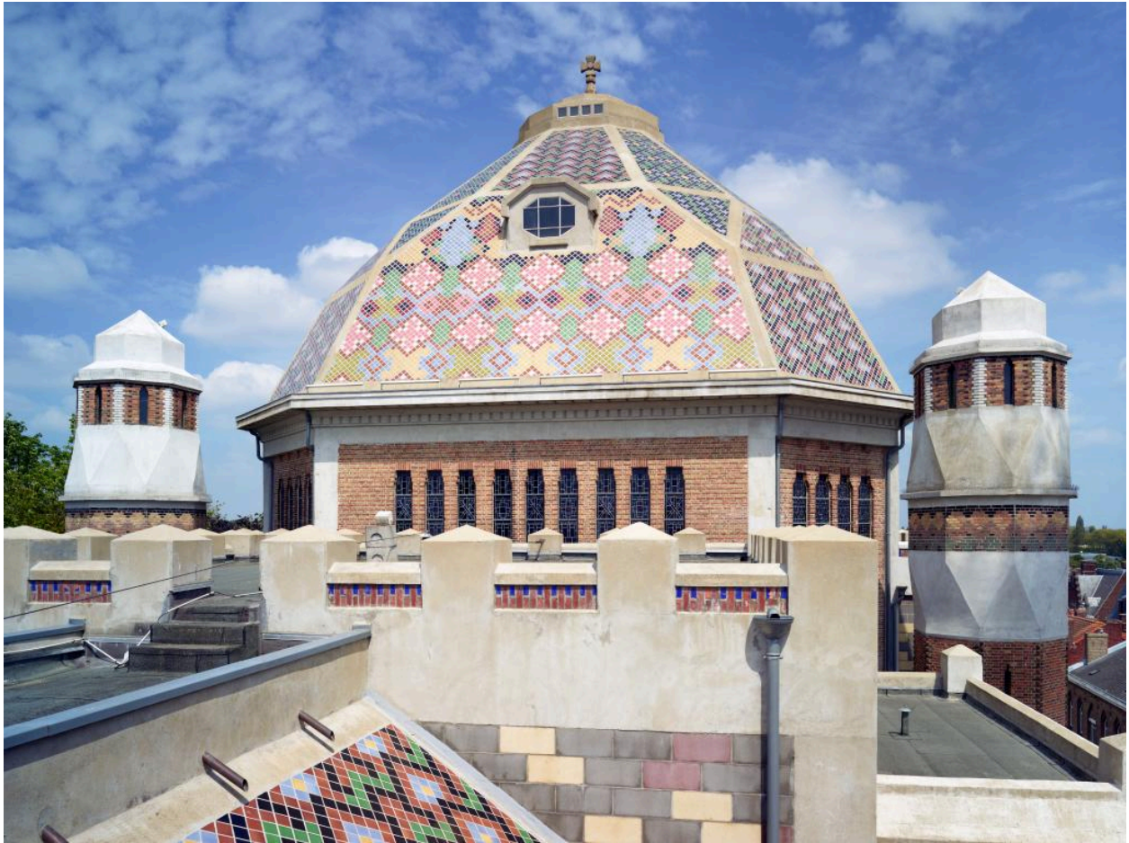
Le dôme de la croisée du transept, vue extérieure.
