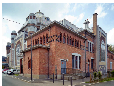
Vue de trois-quarts de la façade est depuis l'angle sud-est. Phot. Pierre Thibaut IVR32_20215900094NUCA
