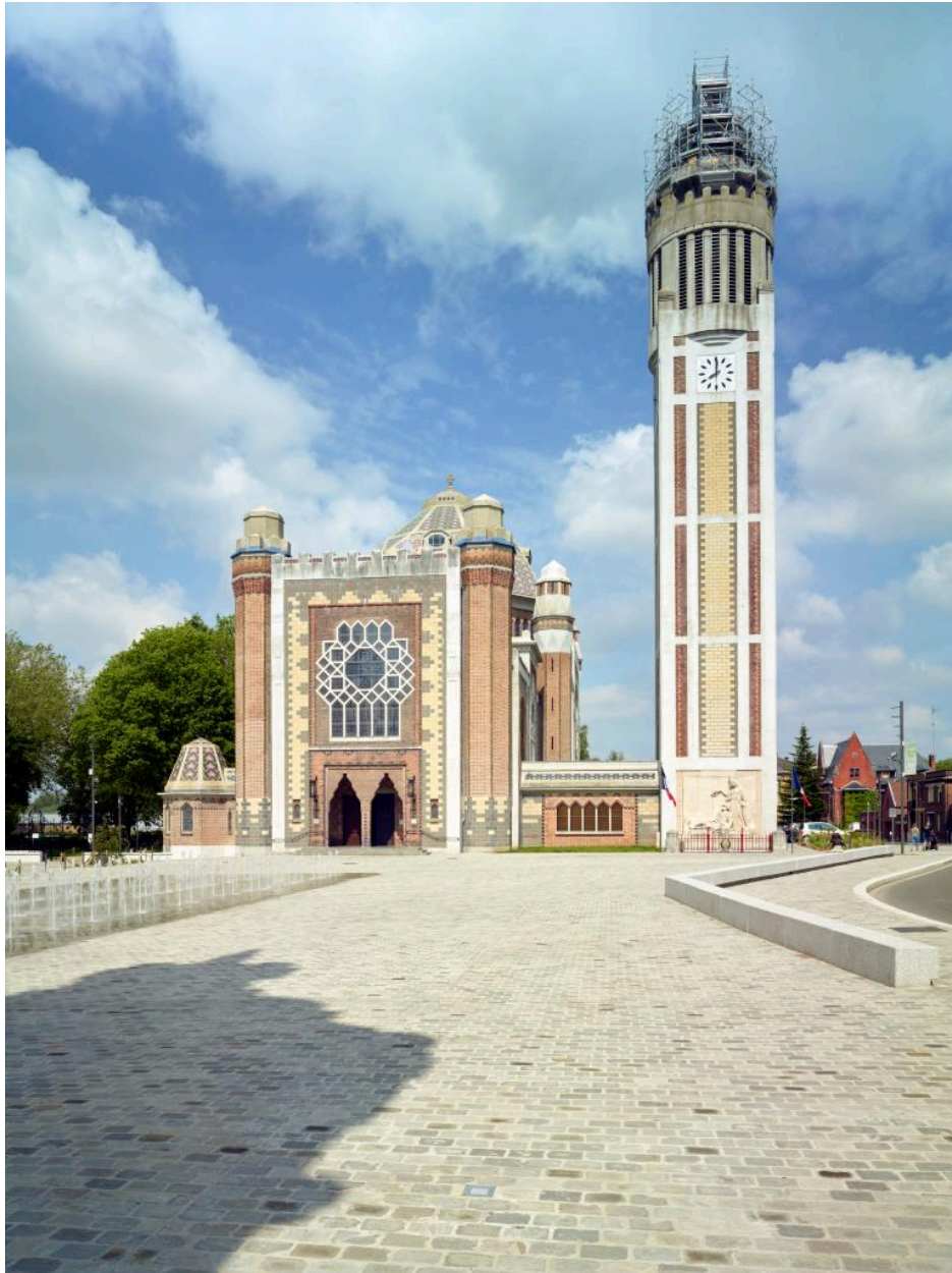
La façade occidentale de l'église donnant sur la Grand'place.
