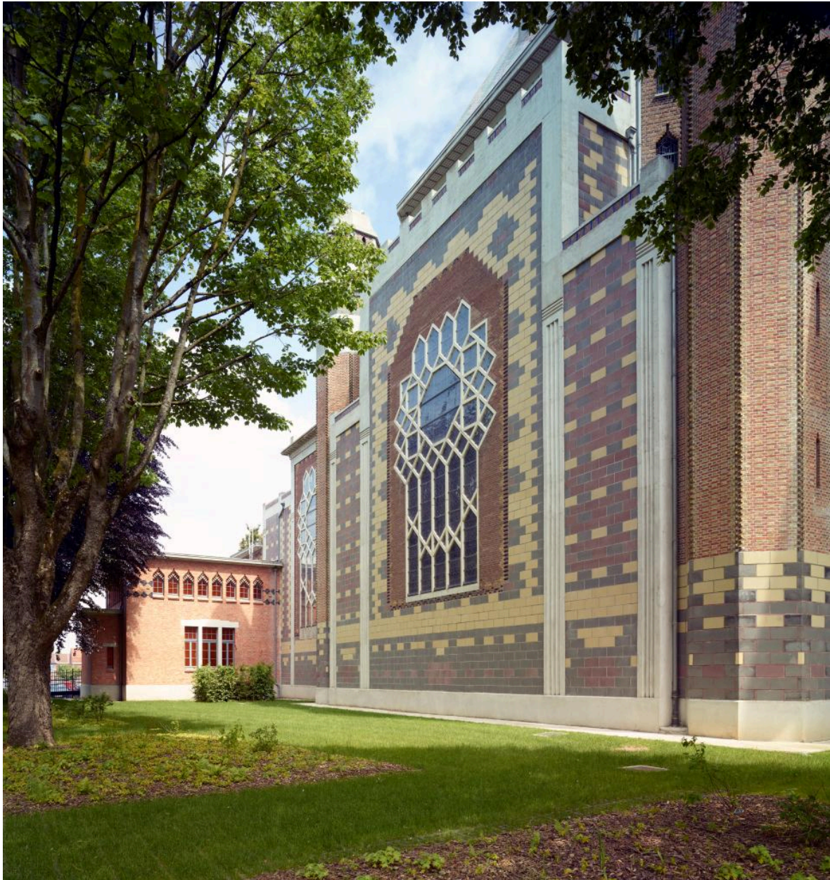
Façade nord, depuis l'angle nord-ouest.
