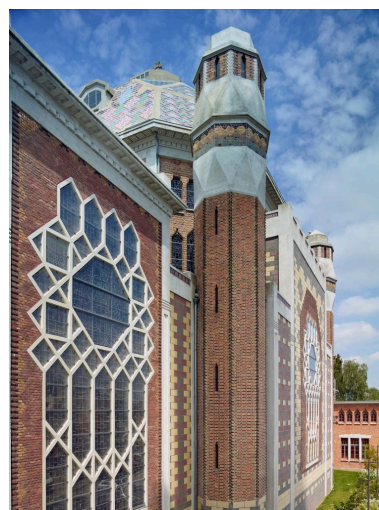
Façade sud du transept prise depuis le clocher de l'église. Phot. Pierre Thibaut IVR32_20215900077NUCA
