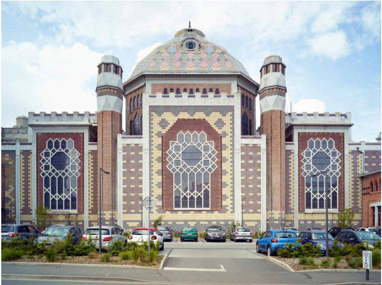
Vue d'ensemble sud.
