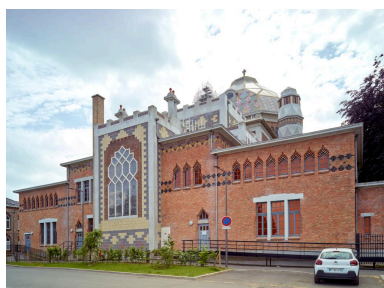
Vue d'ensemble oriental de l'église, avec le chevet au centre, flanqué de la sacristie et de la salle des catéchèses en brique orangée. Phot. Pierre Thibaut IVR32_20215900092NUCA
