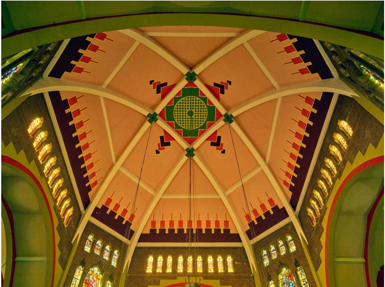
Coupole nervurée du dôme de la croisée du transept.
