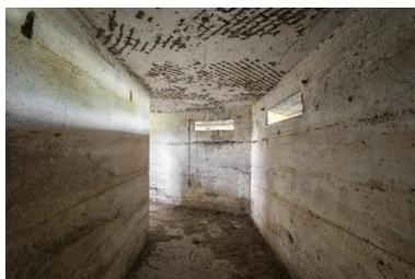
Premier étage, coursière de tir, vers l'est, au grand-angulaire. Des volets horizontaux permettaient d'occulter les embrasures de tir. A droite, on en distingue encore les dispositifs d'attache au mur que le crochet de maintien au plafond
