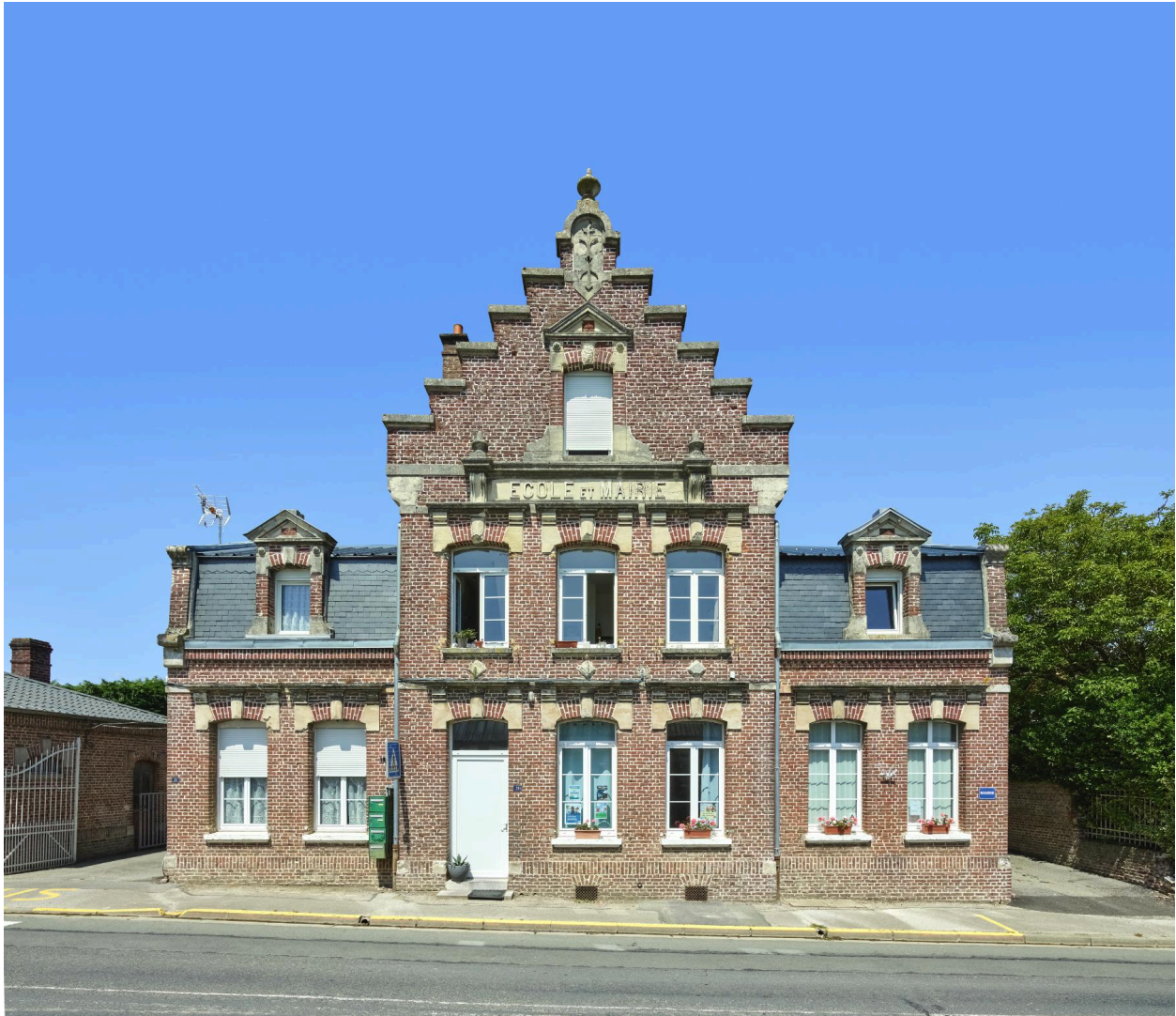
Vue de face, depuis la rue.
