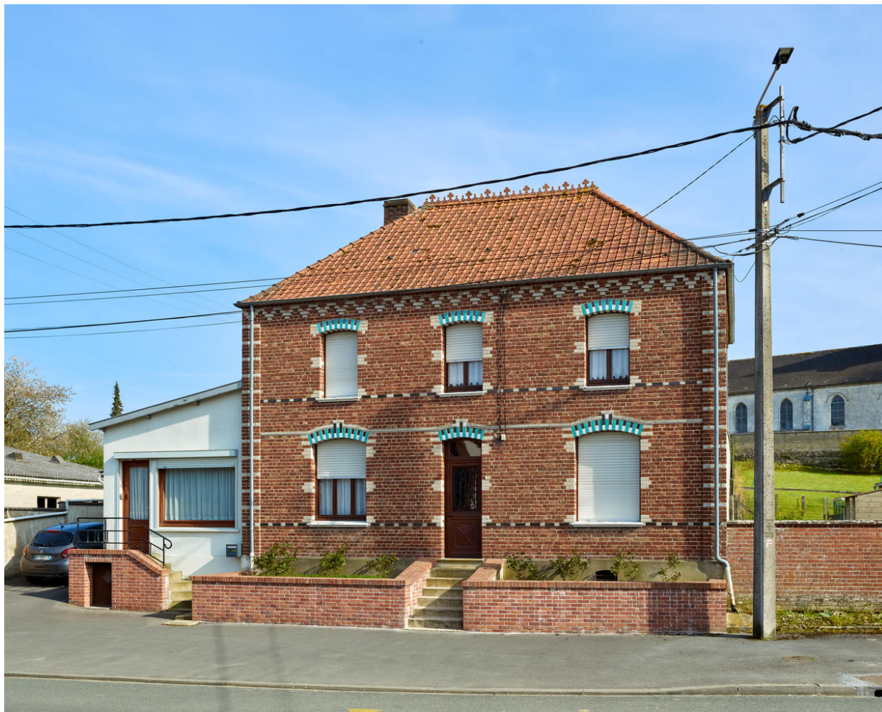
Vue générale de l'élévation sud.
