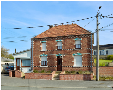
Vue générale de l'élévation sud. Phot. Thierry Lefébure IVR32_20236200569NUCA
