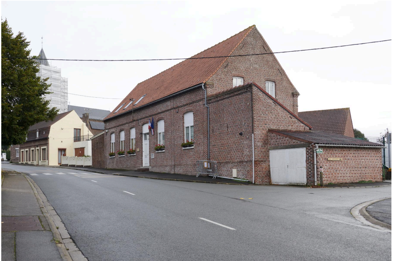
Vue générale depuis le sud.
